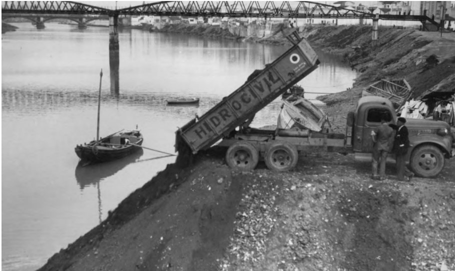
FIGURA 5. Primeros movimientos de tierra en Chapina para crear un dique. Año 1948. Fuente: Fondo Fotográfico de la Autoridad Portuaria de Sevilla.
