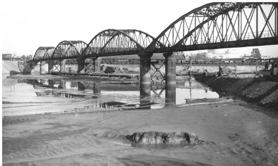
FIGURA 7. Puente ferroviario de Alfonso XII en seco y recrecido el nivel del fondo para crear el tapón. Año 1948. Fuente: Fondo Fotográfico de la Autoridad Portuaria de Sevilla.
