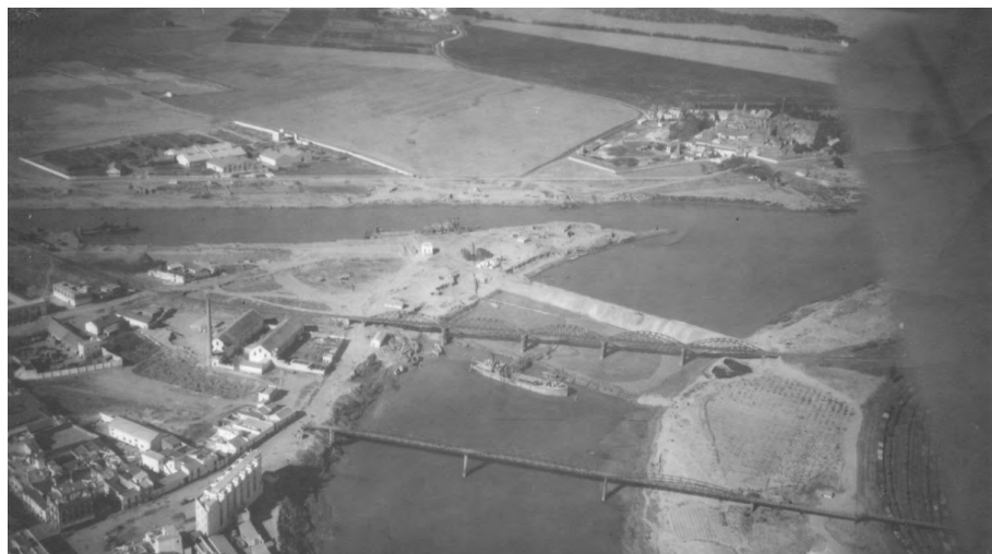
FIGURA 8. Vista aérea de las obras del tapón de Chapina y desvío de la corriente del Guadalquivir por la corta de la vega de Triana. Año 1949. Fuente: Fondo Fotográfico de la Autoridad Portuaria de Sevilla.
