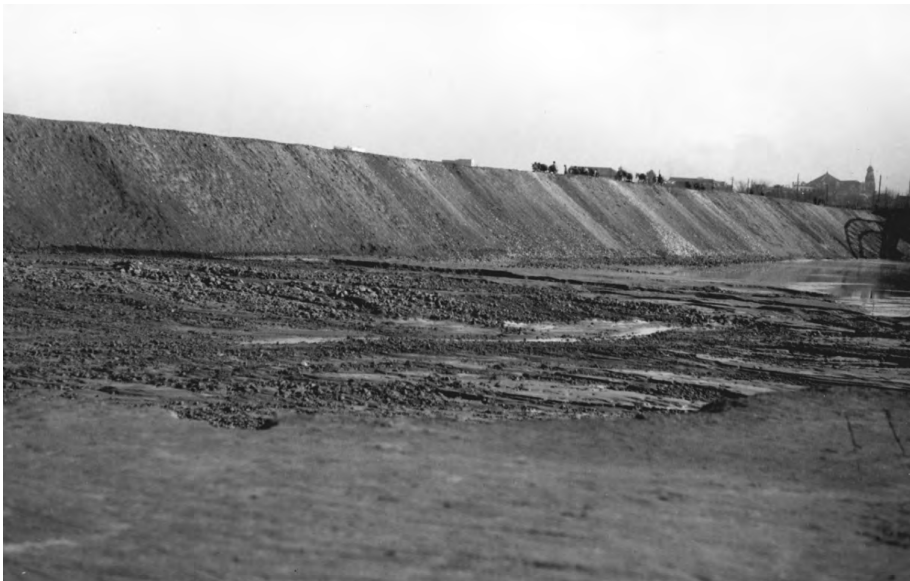
FIGURA 6. Talud levantado en Chapina para impedir la corriente del río. Año 1948. Fuente: Fondo Fotográfico de la Autoridad Portuaria de Sevilla.
