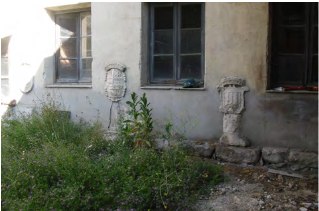
Estado actual del convento. Fotografías Strato.
