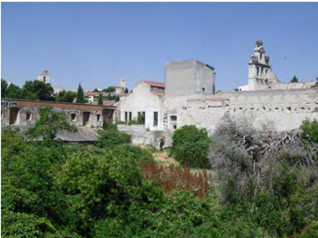
Estado actual del convento. Fotografías Strato.
