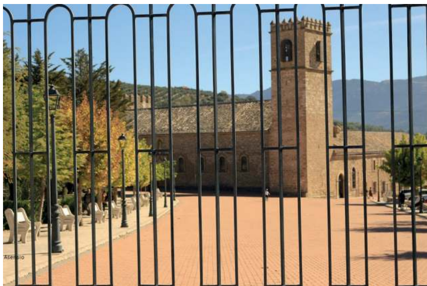
Vista exterior del santuario de la Fuensanta.
