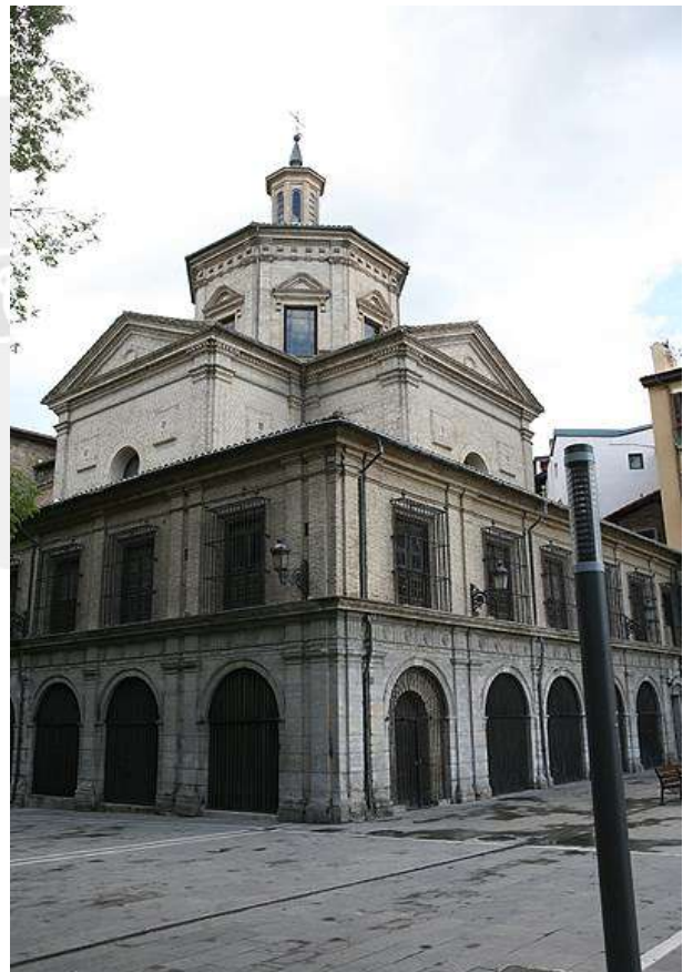
El exterior de la Capilla expresa con claridad el proyecto barroco, concebido como una planta de cruz griega inscrita en un cuadrado.
