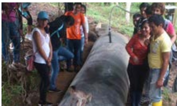
Figura 3. Mezcla de la carga diaria en el biodigester en CIPCA/Santa Clara
