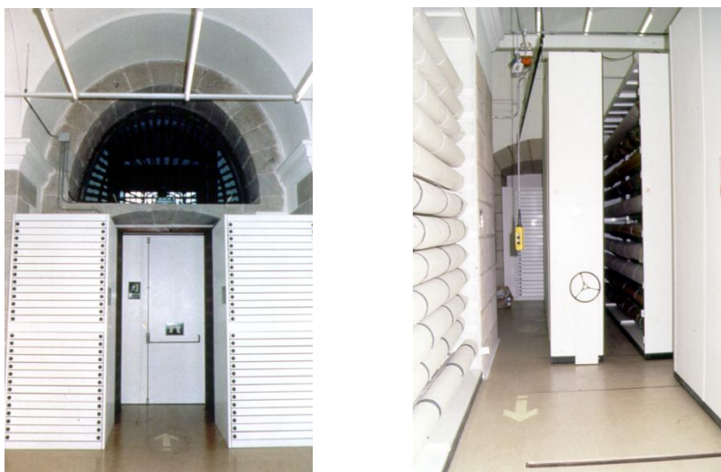
Fig. 8 y 9: Almacén de Tapices del Palacio Real de Madrid. Mobiliario de bandejas y baterías de cilindros. ©Patrimonio Nacional. Fotos de la autora.
