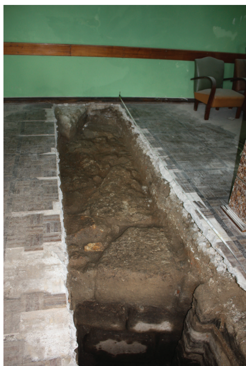
Fig. 2 – Vala de sondagem, onde já se identifica a presença da muralha.
