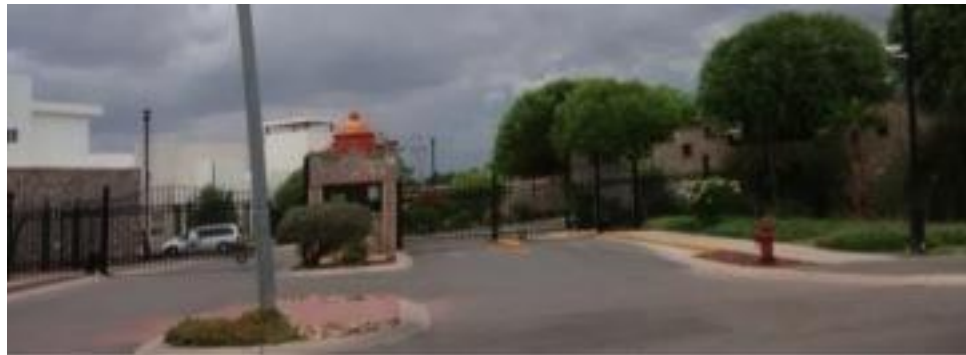
Figura 8. Paisaje Natural y Construido
