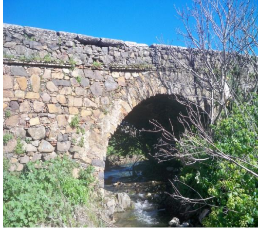
Fig. 7: Puente Viejo sobre el Arroyo Robledillo, en el Camino de Villafranca (Foto Diego Muñoz).
