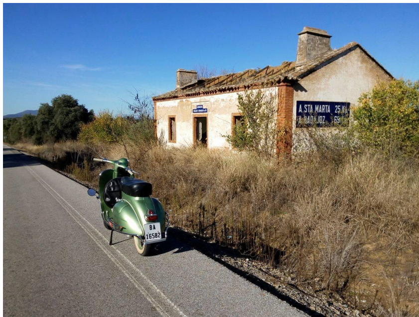
Fig. 20: Casilla de peones camineros en la carretera en dirección a Badajoz (junto a la Dehesa del Rincón).
