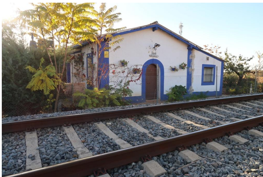
Fig. 32: Antigua casilla de ferrocarril en la abandonada carretera N-630, hoy reutilizada como casa de campo.
