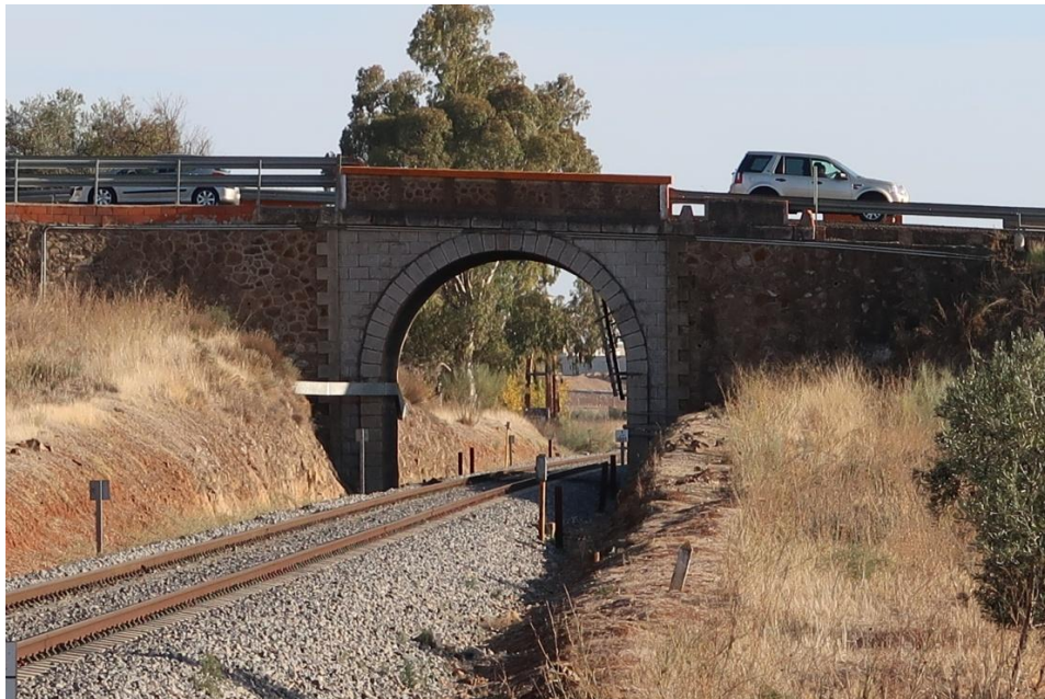
Fig. 28: Puente de la prolongación de la carretera N-435R sobre la línea férrea Mérida-Sevilla.
