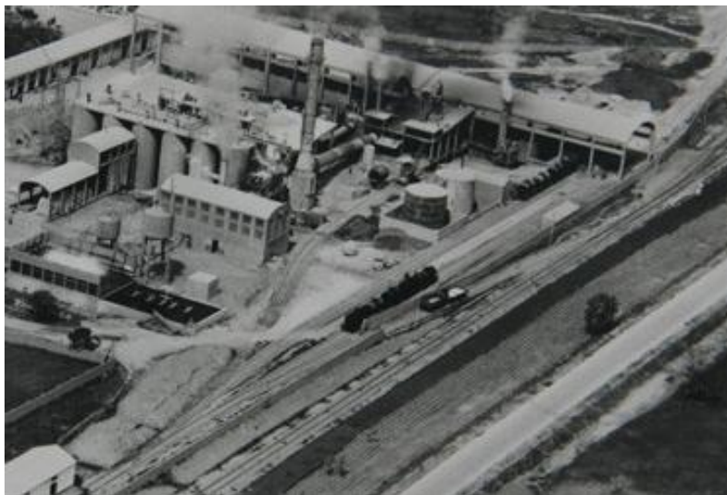
Fig. 37: Línea ferroviaria Mérida-Sevilla, aprovechada aquí con una segunda vía dentro de cementos ASLAND. De derecha a izquierda: carretera N-630 y ferrocarril Mérida-Sevilla (Foto: década de los años sesenta).
