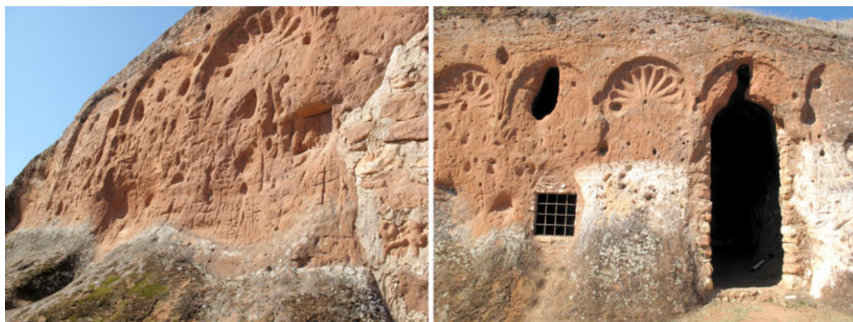
Fig. 12. Eremitorio de Valdecañales. Deterioro por erosión. Fotografías: María Higuera Muñoz.
