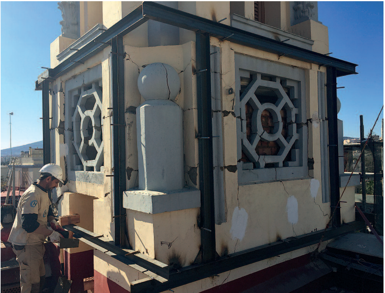
(Figura 3) Zunchado de emergencia y cierre de huecos.
