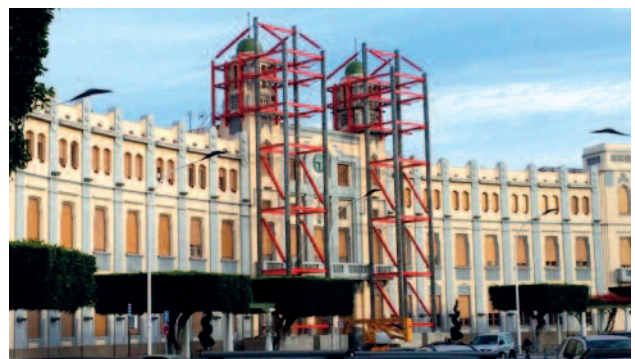
(Figura 4) Estructuras de estabilización de los torreones.
