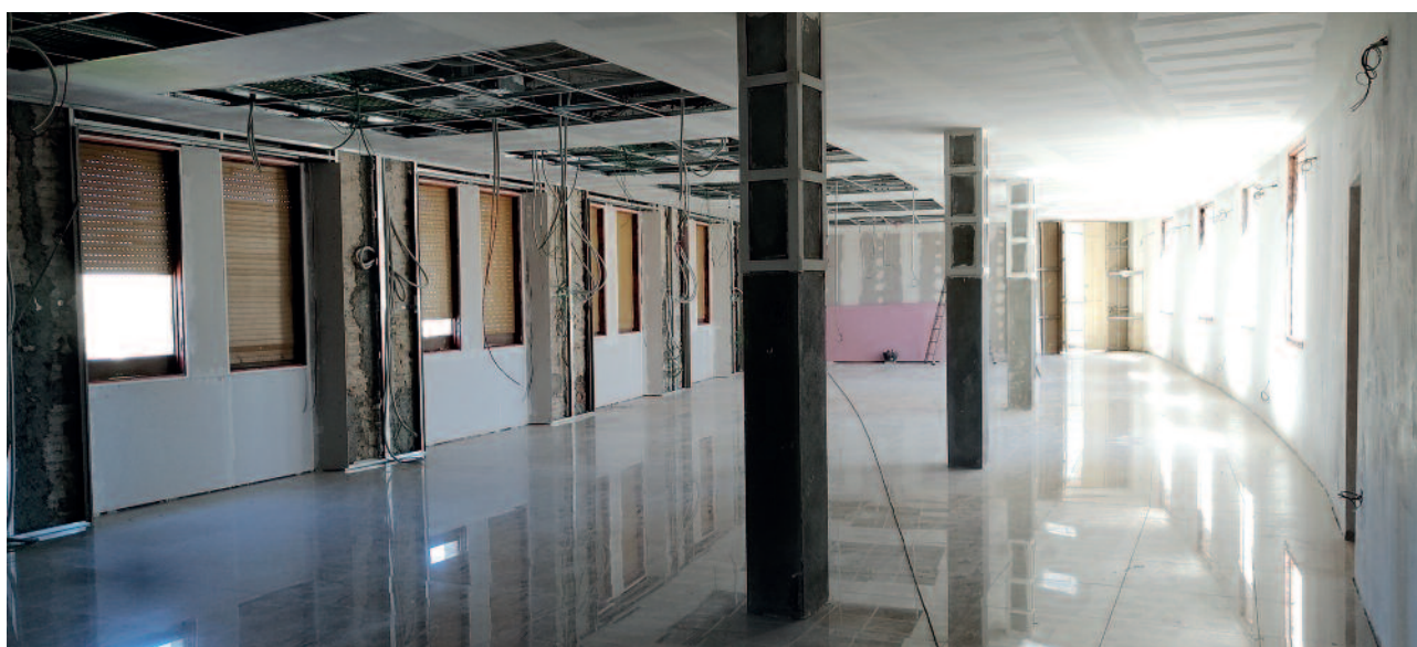
(Figura 10) Estado actual actuaciones planta segunda zona central.
