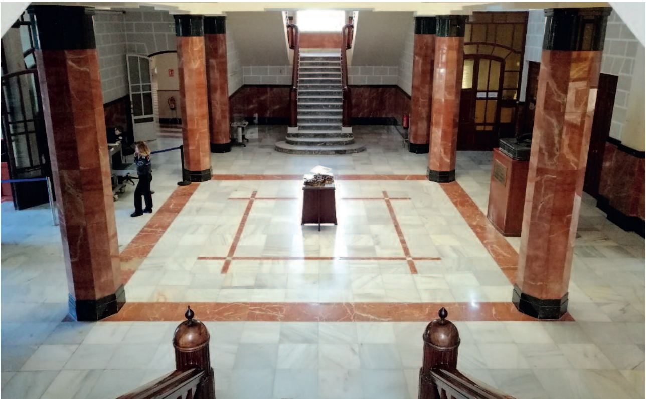
(Figura 6) Reparación pilares y resto vestíbulo central.
