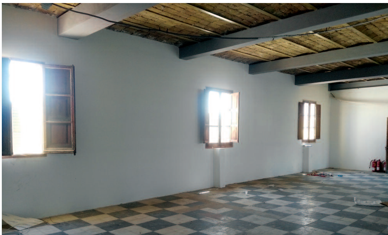
(Figura 8) Sala del reloj una vez reforzada.
