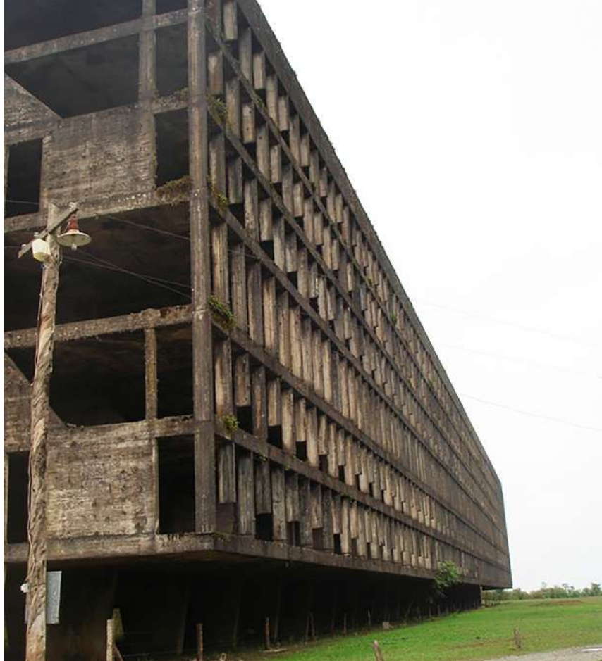
Figura 8: Vista de la estructura de hormigón armado del block para residencia de estudiantes varones. Fuente: Fotografía de Susana Villavicencio (2009).
