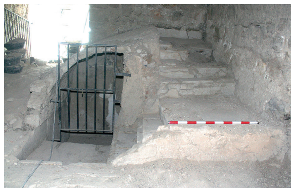
Fig. 26: Planta Tercera. Escalera arruinada que comunicaba la Planta Segunda y el terrado a partir de las reformas del siglo XVI. Sustituyó a la medieval primitiva del siglo XIII.
