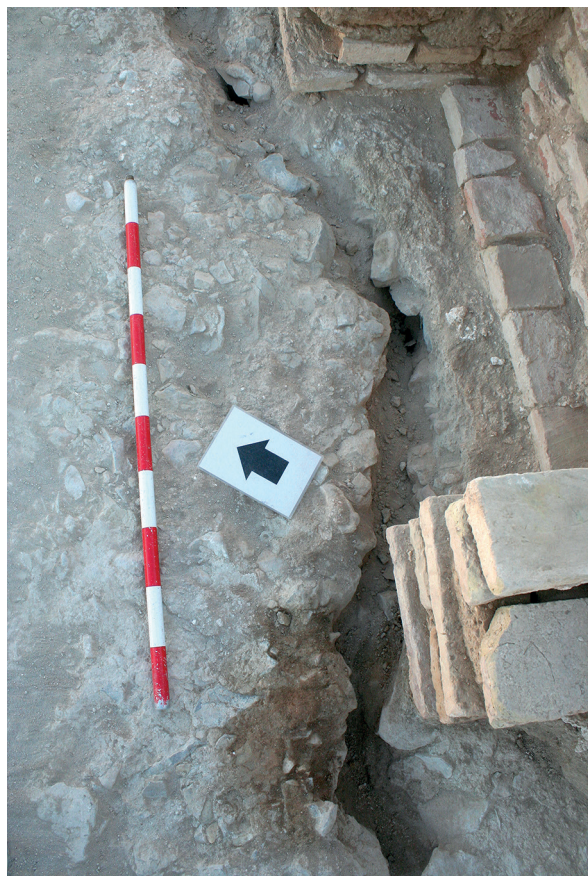
Fig. 6: Terrado. Las grietas estructurales localizadas durante la ejecución de los trabajos que se pueden relacionar con los efectos provocados por movimientos sísmicos históricos son abundantes y, en ocasiones, de una patología extrema.
