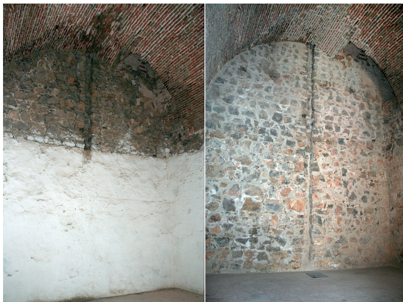
Fig. 75: Planta Segunda. Estado anterior y posterior a los trabajos realizados tras la eliminación de enlucidos y encalcos sin interés y restauración puntual de la bóveda.
