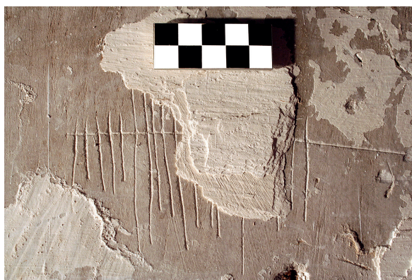
Fig. 78: Planta Segunda. Caja de escalera del siglo XVI (U.E. 500). Ejemplo de grafito de contabilidad asociado al uso como granero de la torre (siglos XVIII-XX).
