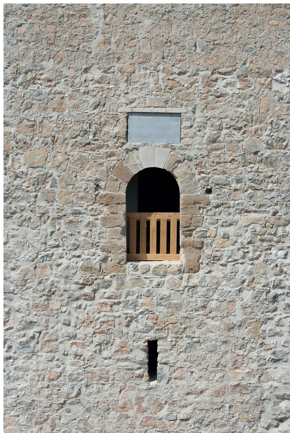
Fig. 40: Fachada 1. Entrada original a la torre (Planta Segunda), al término de los trabajos de consolidación. Sobre la puerta se conserva la mortaja de la inscripción fundacional, hoy perdida. Abajo, el respiradero del aljibe (planta inferior).
