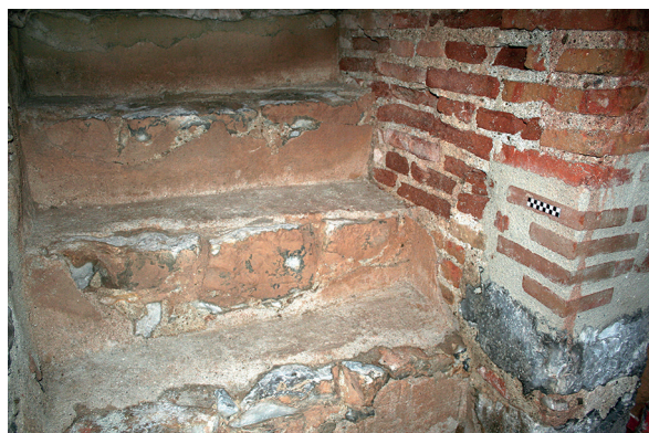
Fig. 63: Escaleras originales (s. XIII) conservadas en el paso entre las plantas Segunda y Tercera. Tramo con escalones ejecutados con mampostería caliza y restos de enlucido de una fase probablemente bajomedieval, si bien mantenida con posterioridad.
