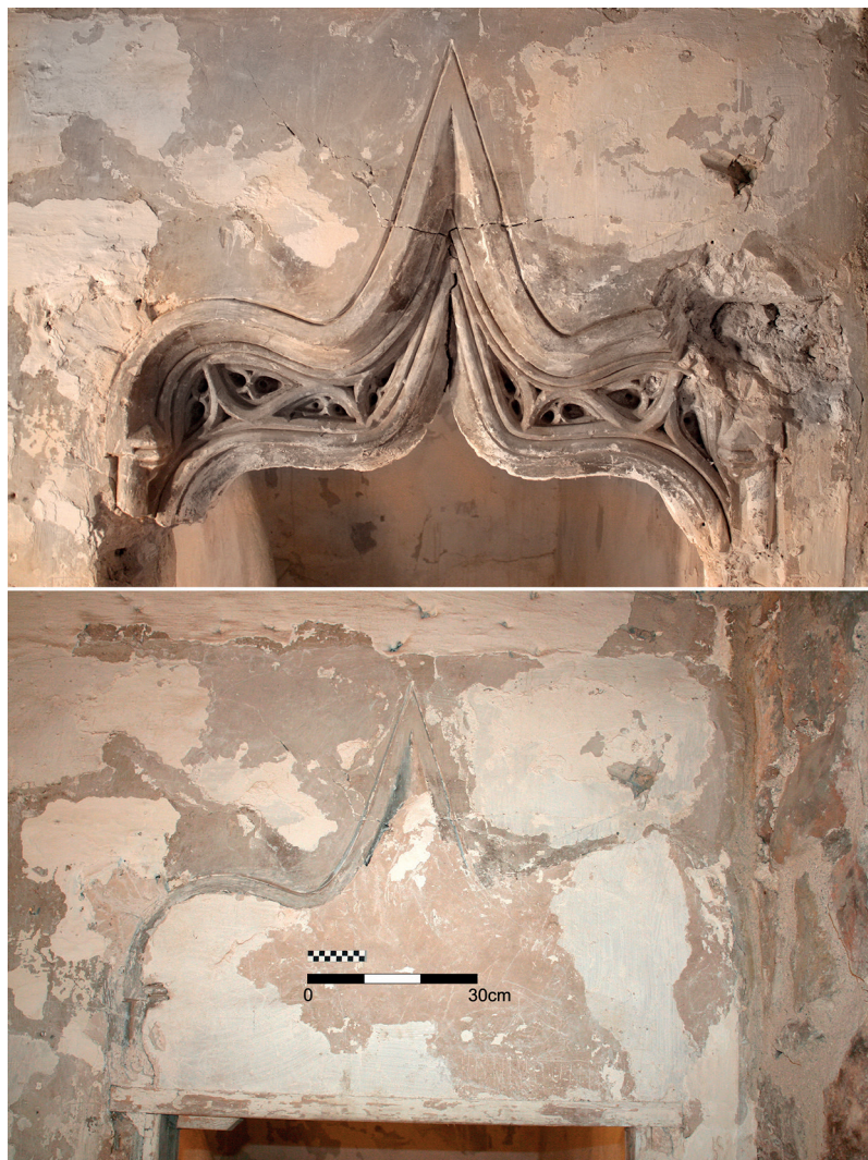
Fig. 73: Planta Segunda. Arco conopial decorado con tracería gótica (s. XVI) recuperado durante los trabajos. Estado posterior y previo (avanzado).
