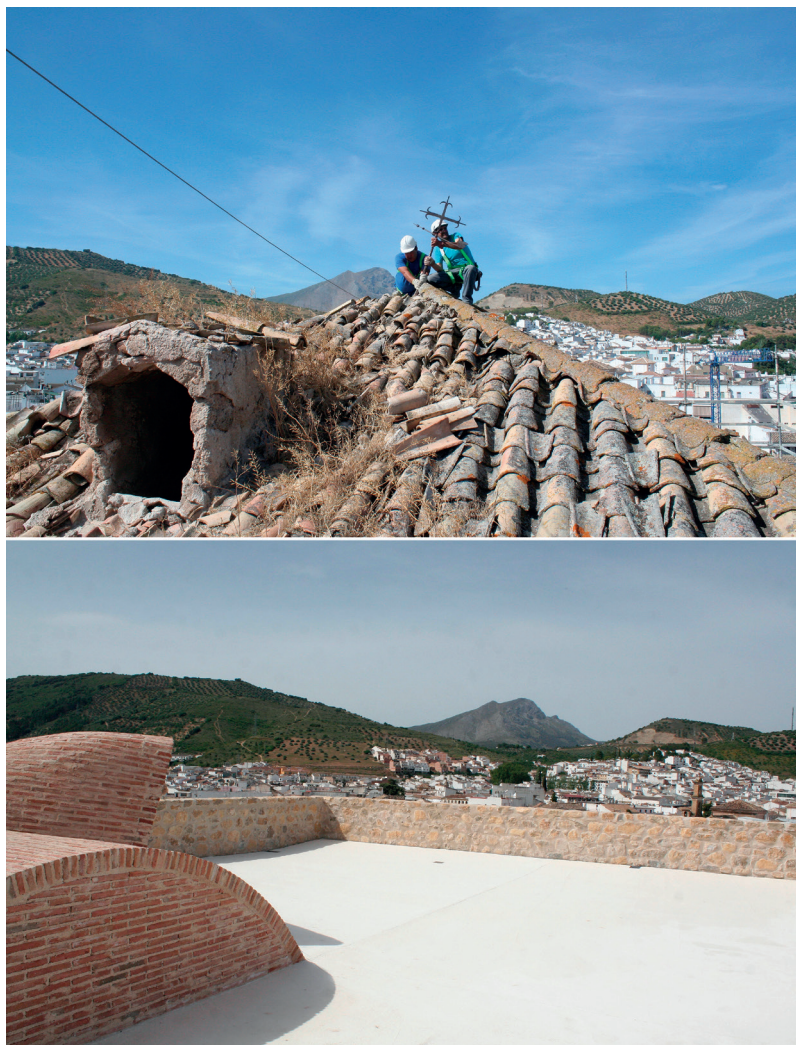
Fig. 8: Terrado. Inicio de los trabajos de dismantelamiento de la cubierta de teja de la torre y aspecto final.
