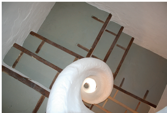
Fig. 72: Escalera de caracol (de Mallorca), del siglo XVI, perteneciente a las obras de adecuación de la torre como residencia señorial. Estado final tras las obras.
