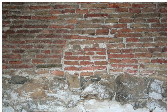
Fig. 79: Planta Segunda. Ejemplo de mechinal amortizado perteneciente a la cimbra de la bóveda de ladrillo (Tipo 5) (s. XIII).
