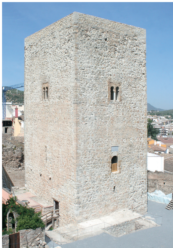
Fig. 3: Panorámica general de la torre al término de los trabajos de consolidación.
