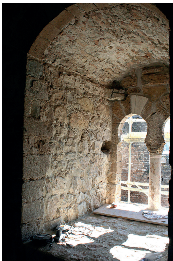
Fig. 57: Planta Tercera. Cámara del Ajimez 2 en una fase avanzada de la ejecución de los trabajos, con la estructura consolidada, la plataforma reconstruida y reintegradas dos de las dovelas de uno de los arcos.
