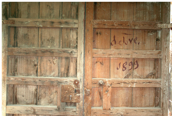
Fig. 42: Planta Primera. Interior de las puertas que cierran el vano actual de acceso a la torre, con grafito trazado en rojo de almagra: Sebre. 1899 (septiembre de 1899).
