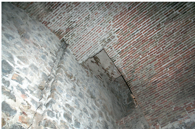
Fig. 21: Planta Segunda. Localización en este sector de la mortaja del bajante de atadores (no conservados) que evacuaban el agua de lluvia caída en el terrado hasta el aljibe de la planta inferior. A la derecha, paso original (s. XIII) de conexión con la Planta Tercera.
