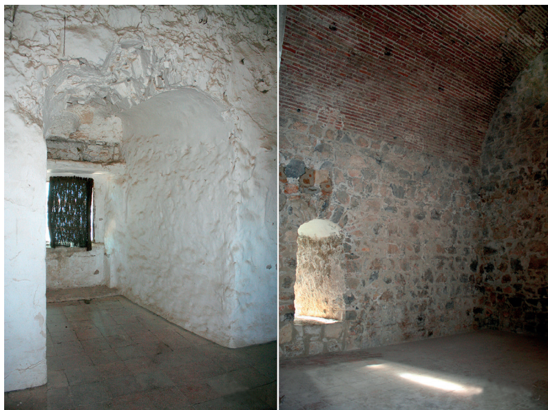
Fig. 74: Planta Segunda. Estado anterior y posterior a los trabajos realizados, con recuperación de ventana aspillerada original (s. XIII) y eliminación de enlucidos y encalos sin interés.
