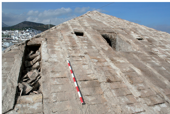
Fig. 10: Terrado. Aspecto de la cubierta una vez retiradas las tejas.
