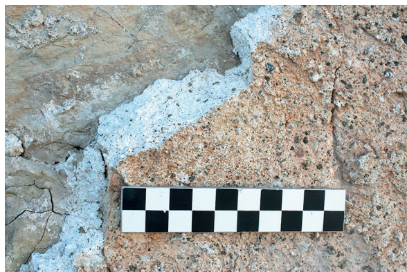
Fig. 53: Fachada 2. Detalle de mortero de cal pigmentado en superficie con coloración en tonos ocres de origen no antrópico.
