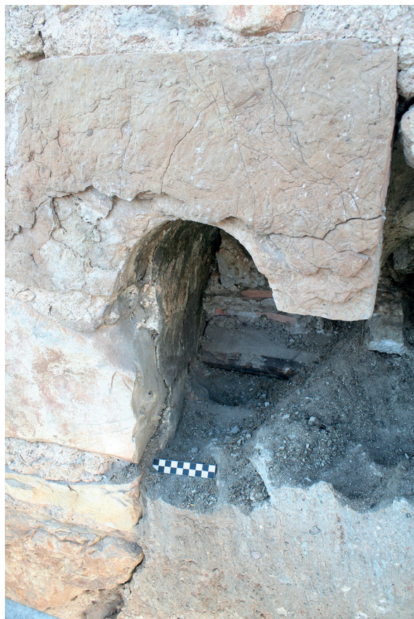
Fig. 77: Planta Segunda. Aspillera de la Fachada 2 (exterior) en proceso de recuperación. Conserva parte de un enlucido original (s. XIII) (U.E. 121) que se mantiene tras la finalización de las obras.
