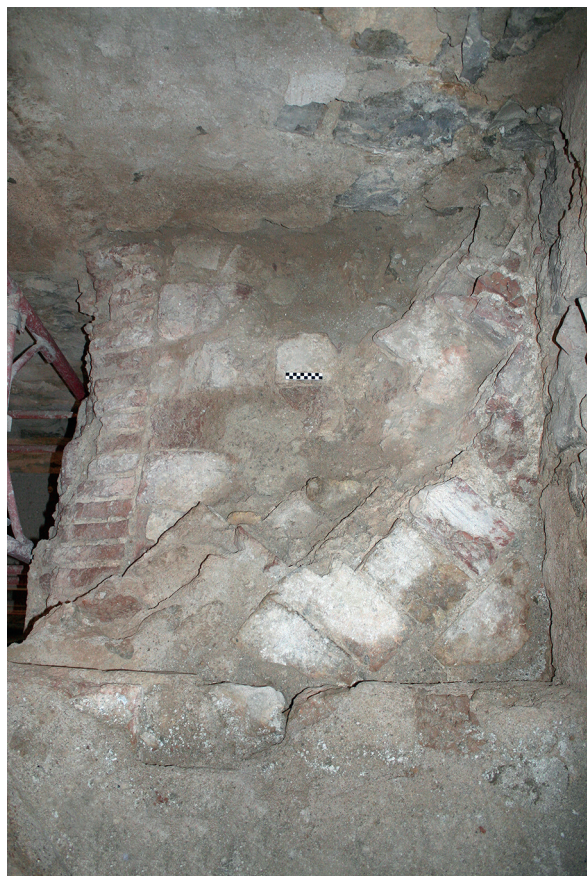
Fig. 62: Escaleras originales (s. XIII) conservadas en el paso entre las plantas Segunda y Tercera. Presentan los dos escalones inferiores de ladrillo y el resto de mampostería caliza.
