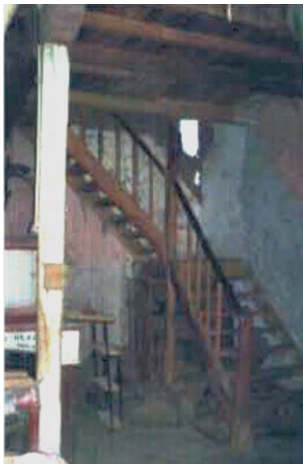
Escalera interior del molino. Fuente: Archivo personal.
