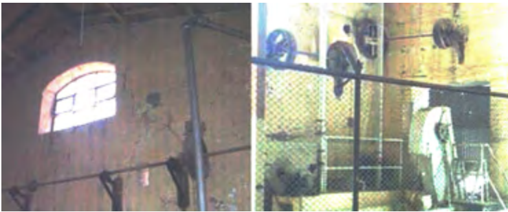
Arriba: Eje distribuidor y cinta de cangilones con su polea. A la derecha: Adaptación a los muros de adobe del molino al lagar y la cinta con cangilones Centro: Antiguo molino Mauricio. Abajo: Cinta, polea y eje de distribución. La polea gira con el movimiento de la noria.
