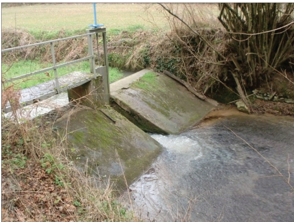
Figura 2. Vista aguas abajo de la presa y el caudal que pasa a través de ella.
