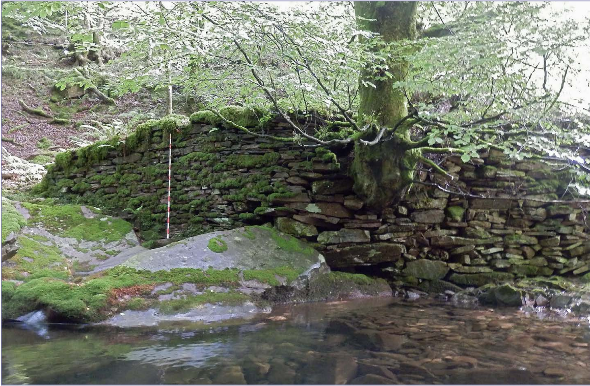
Fig. 5. Inicio de la primera estructura, detrás transcurriría el canal, segunda instalación de Sarasain. Fuente: elaboración propia.
