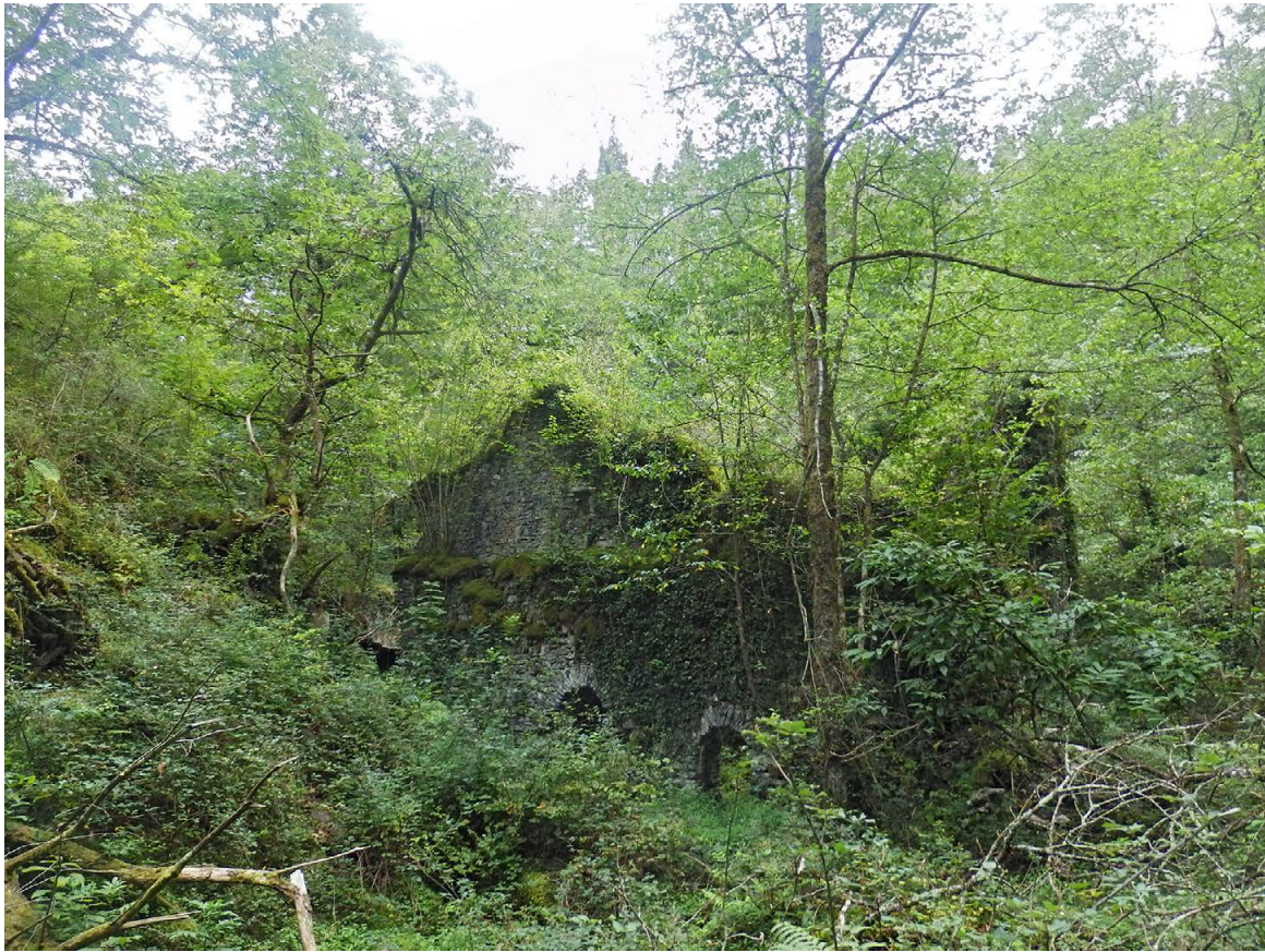
Fig. 8. Estructura del taller de Urdiñola vista desde el exterior. Fuente: elaboración propia.
