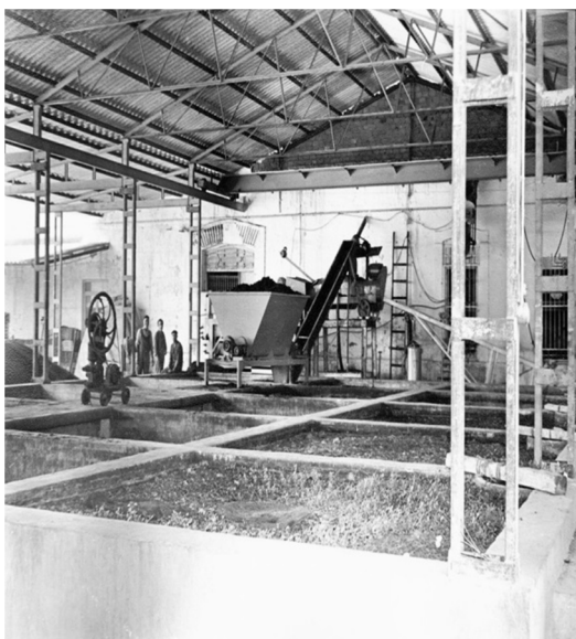
Fig. 6.- Sala de molienda de la aceituna de la Cooperativa El Progreso
