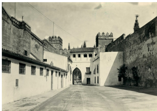
Figura 4: Autor desconocido, c. 1934. Patio del León antes de las intervenciones del arquitecto municipal Juan Talavera y Heredia.
