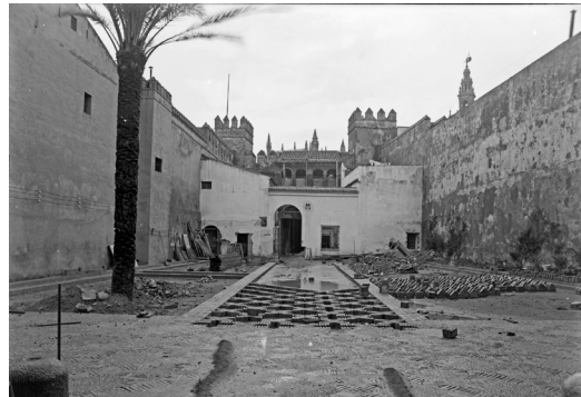
Figura 8: Juan José Serrano Gómez, c. 1934. Patio del León durante la fase de ejecución de las solerías.
