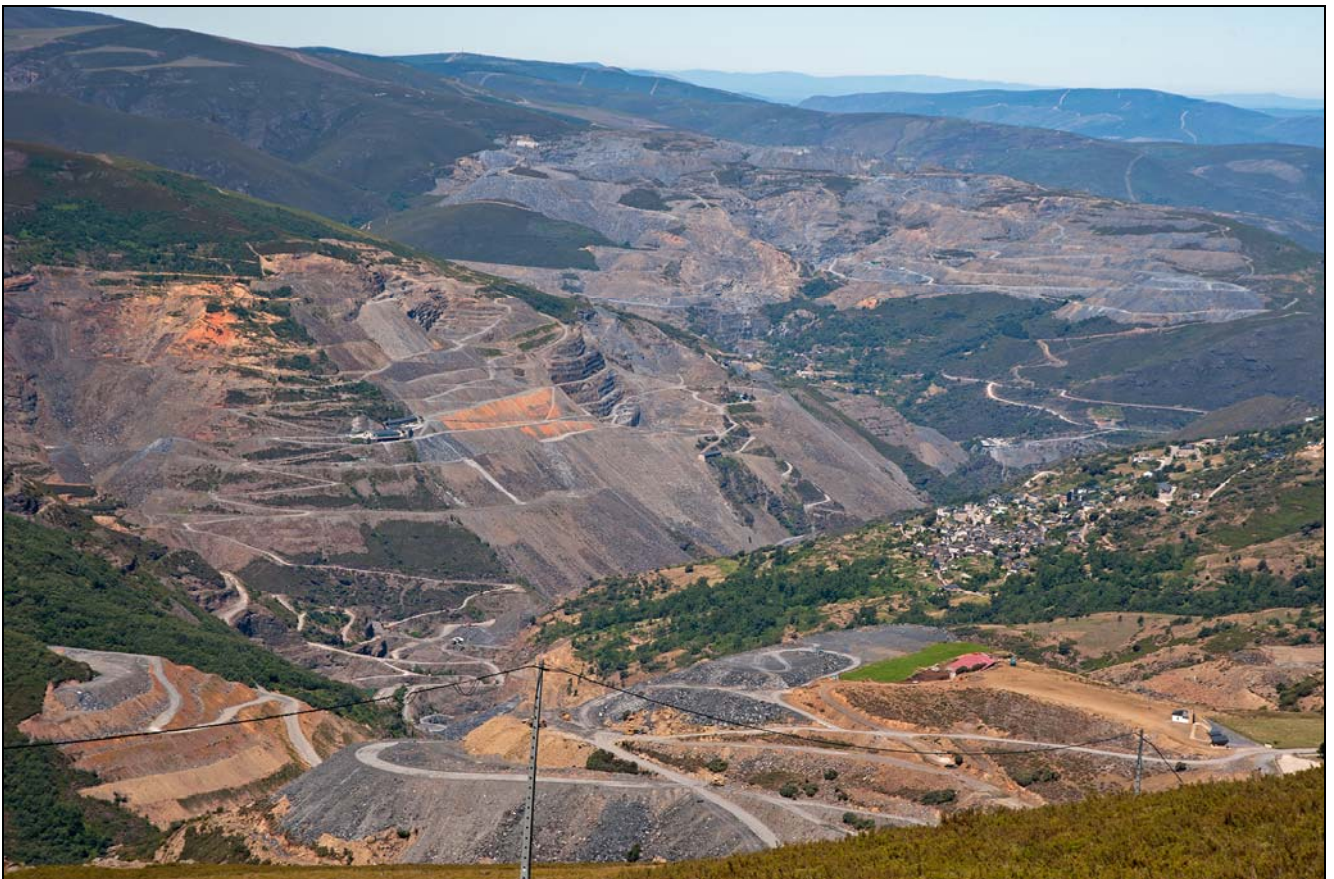
Figura 2. Laderas de Trevinca soterradas por la actividad de la industria de la pizarra que eliminan todo el ecosistema. En primer plano, a la derecha, el pueblo de Casaio (Carballada de Valdeorras, 2017, Ourense) (Foto: R. Estévez).
