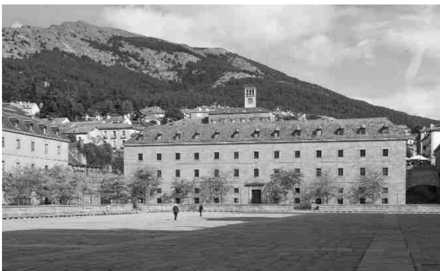
Casa del Ministerio de Estado vista desde la Lonja del Monasterio
