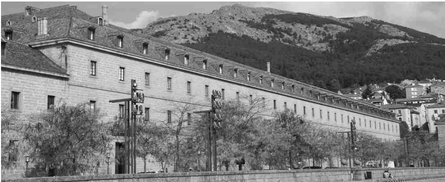
Casa de los Infantes o Segunda Casa de Oficios. Fachada principal a la Lonja del Monasterio.
