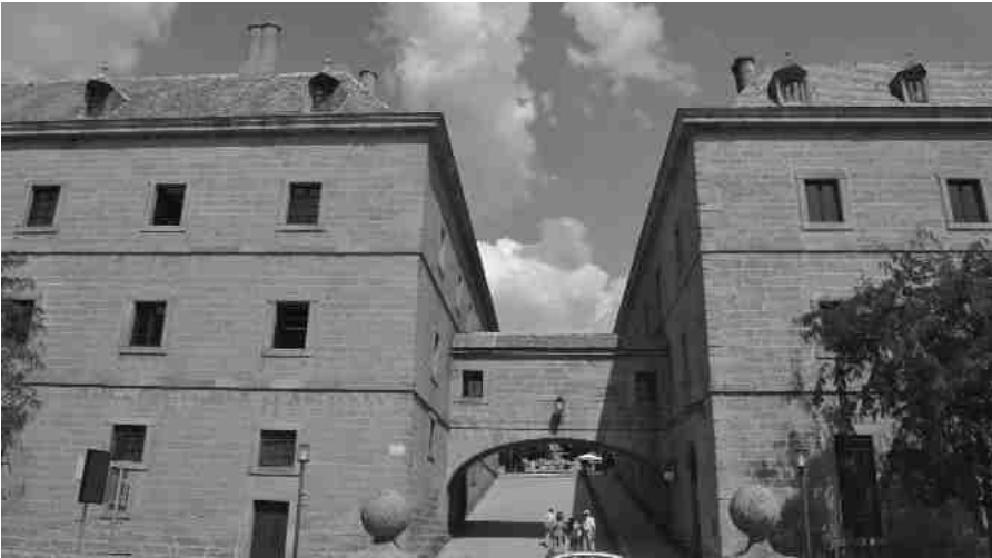
Cuesta de Grimaldi con el arco rebajado o carpanel que une las Casas de Oficios.
