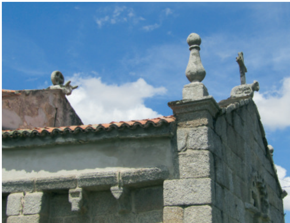
Fig. 5. Acróteras con forma de toro y de carnero en los testeros de la iglesia de Oza dos Ríos, en Cesuras.
