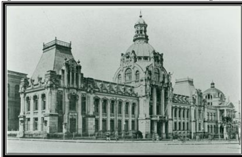
Figura 1 – Instituto Júlio de Castilhos – Vista do edifício. Porto Alegre, 1927-1928.
