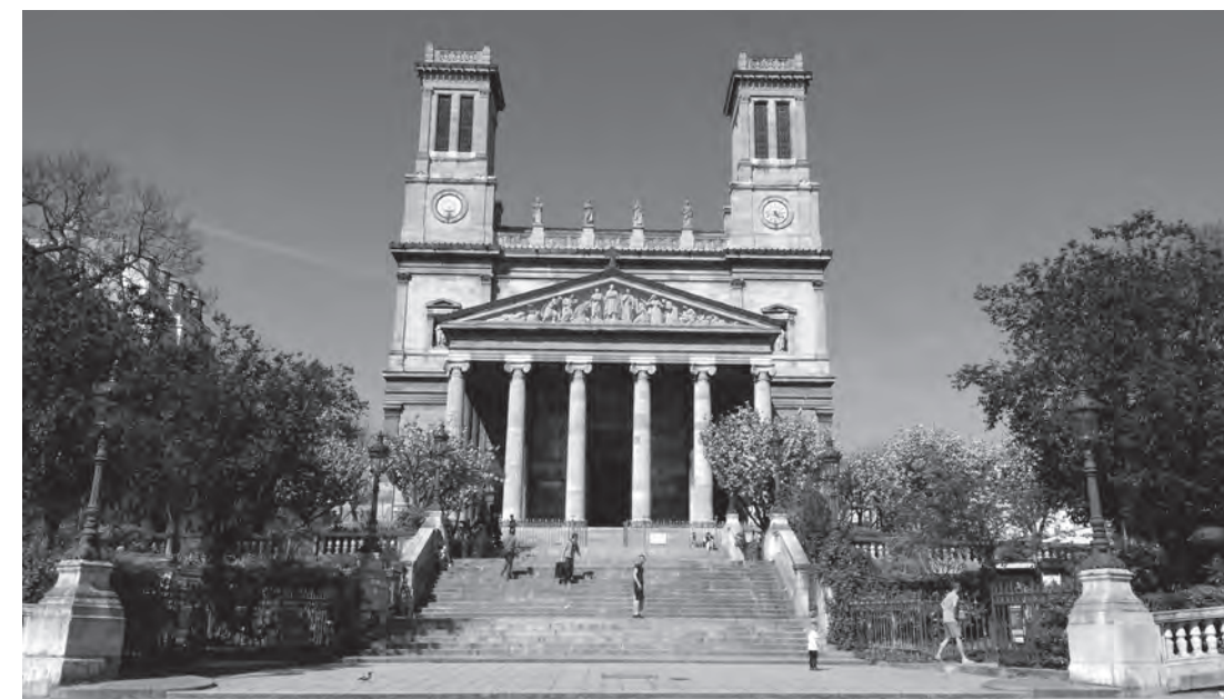
Figura 7. Vista actual de la Iglesia Saint-Vincent de Paul. Fuente: Fotografía de Andrés Avila Gómez, 2018.
