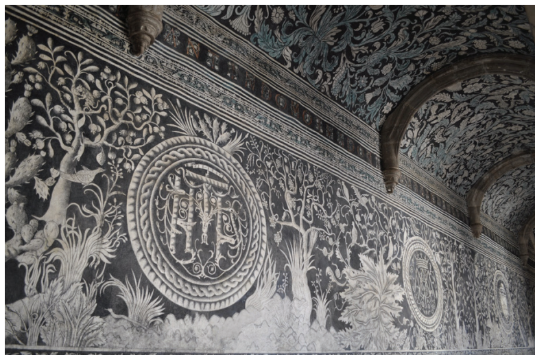
Figura 3. Vista general del muro sur del Convento de la Transfiguración de Malinalco
