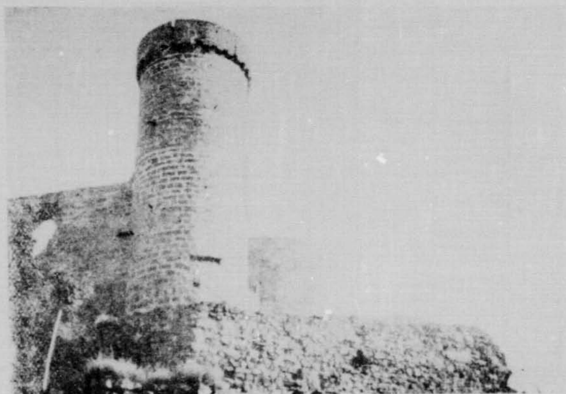
FIGURA 4. a —Torreón del S.; a la derecha, torreón del O.; en primer término muro de construcción anterior al castillo.
