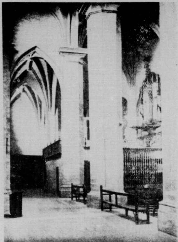
CALEAHORRA. — Parroquia de San Andrés. Nave lateral.
