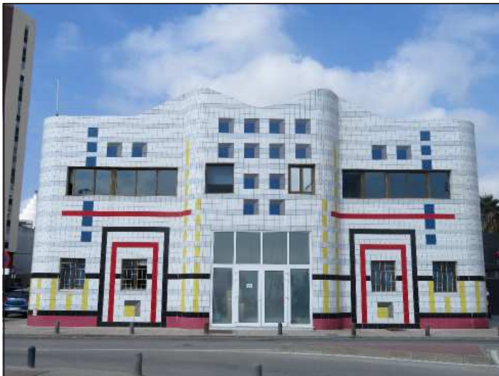
Ilustración 2.- Fachada este del Edificio Sestibalsa-Auditorio Millán Picazo (1993-2005). Espacio Guillermo Pérez Villalta, Algeciras.
