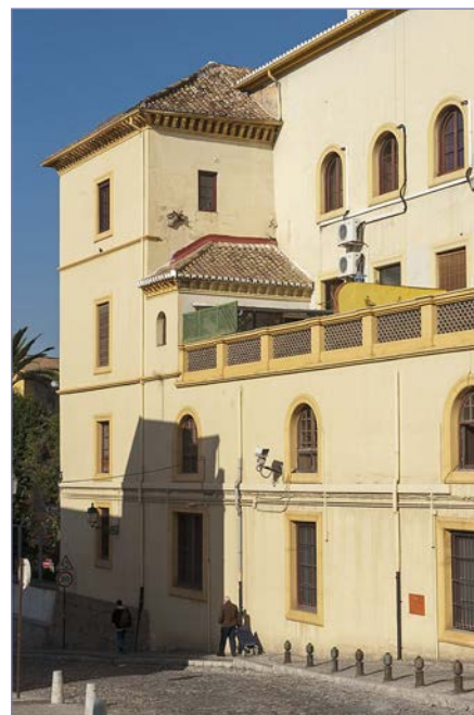
Fig. 16. Antigua Convento de la Merced. Instituto Andaluz del Patrimonio Histórico. [Consulta: 01/06/17] Disponible en: http://www.iaph.es/patrimonio-inmueble-andalucia/resumen.do?id=i260
