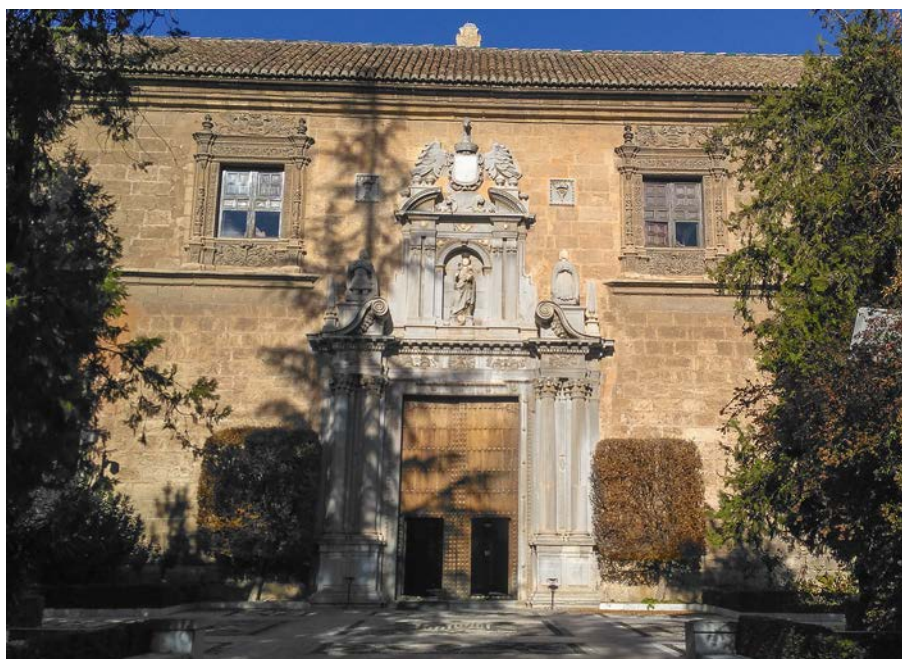
Fig. 5. Fachada del Hospital Real. Fuente propia
