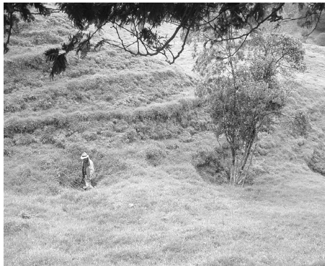
Foto 14. Colapso de chimeneas a lo largo de un corredor cóncavo en los flancos de las concavidades de primer orden.
