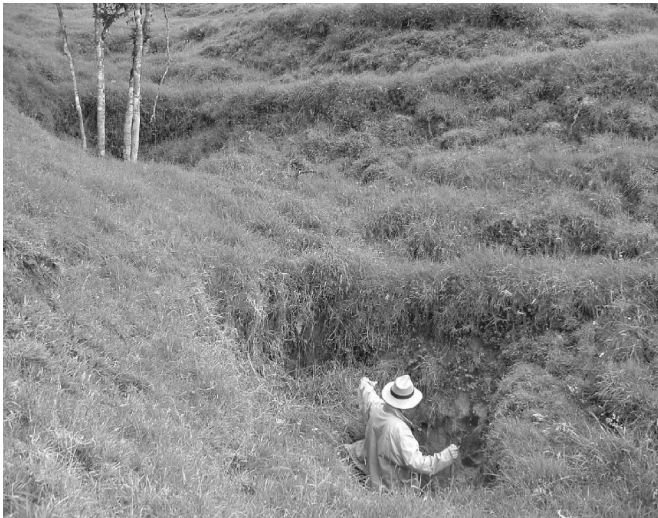
Foto 15. Sobretecho colapsado de chimeneas modeladas en materiales del perfil de meteorización de la cuarzodiorita del Batolito Antioqueño. Las fotos 18 a 19 son tomadas en el mismo sector.
