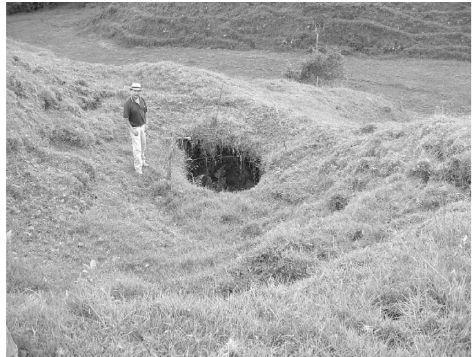
Foto 16. Desplome del sobretecho de una chimenea en el eje de una concavidad.
