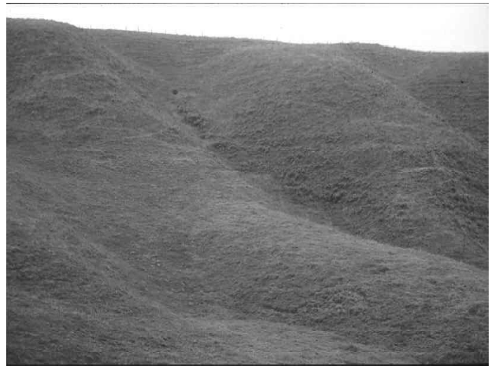
Foto 4. Desarrollo de corredores cóncavos en flancos de colina. En el eje de estos corredores cóncavos se presentan fenómenos de erosión interna (túneles y chimeneas) y colapso del terreno. Ver punto negro en la parte superior de la concavidad en la parte central de la foto.
