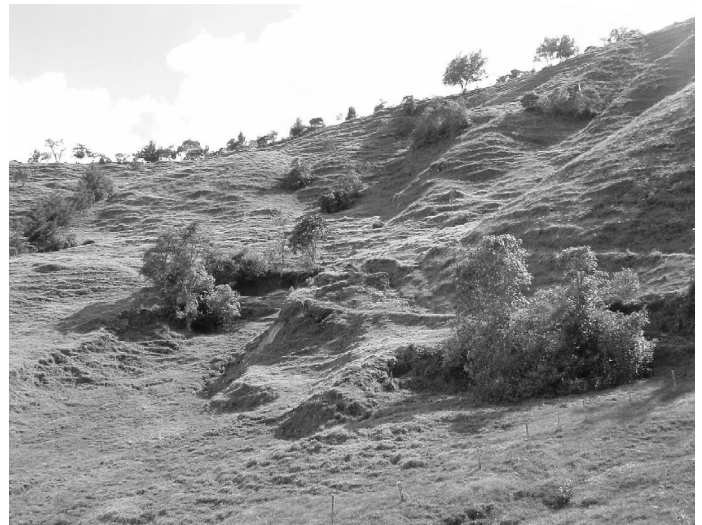
Foto 18. Distribución espacial de hundimientos de sobretechos de túneles y chimeneas en las vertientes. La vegetación arbustiva se ubica en los sitios de desplome del terreno.
