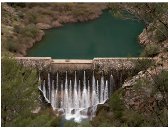
Figura 5. Presa de retención en el Río Turón, que lamina las avenidas fluviales y las aportaciones subterráneas de la Sierra Blanquilla.
