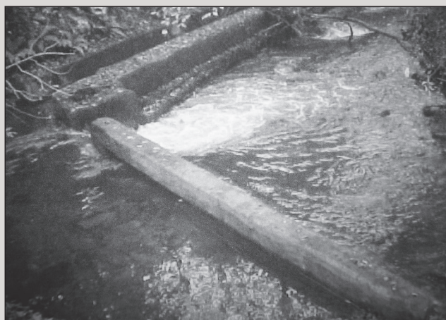
AZUD BAJO EL PUENTE DEL CARBAYAL. FOTO DEL PROYECTO. CONFEDERACIÓN HIDROGRÁFICA DEL MIÑO.
