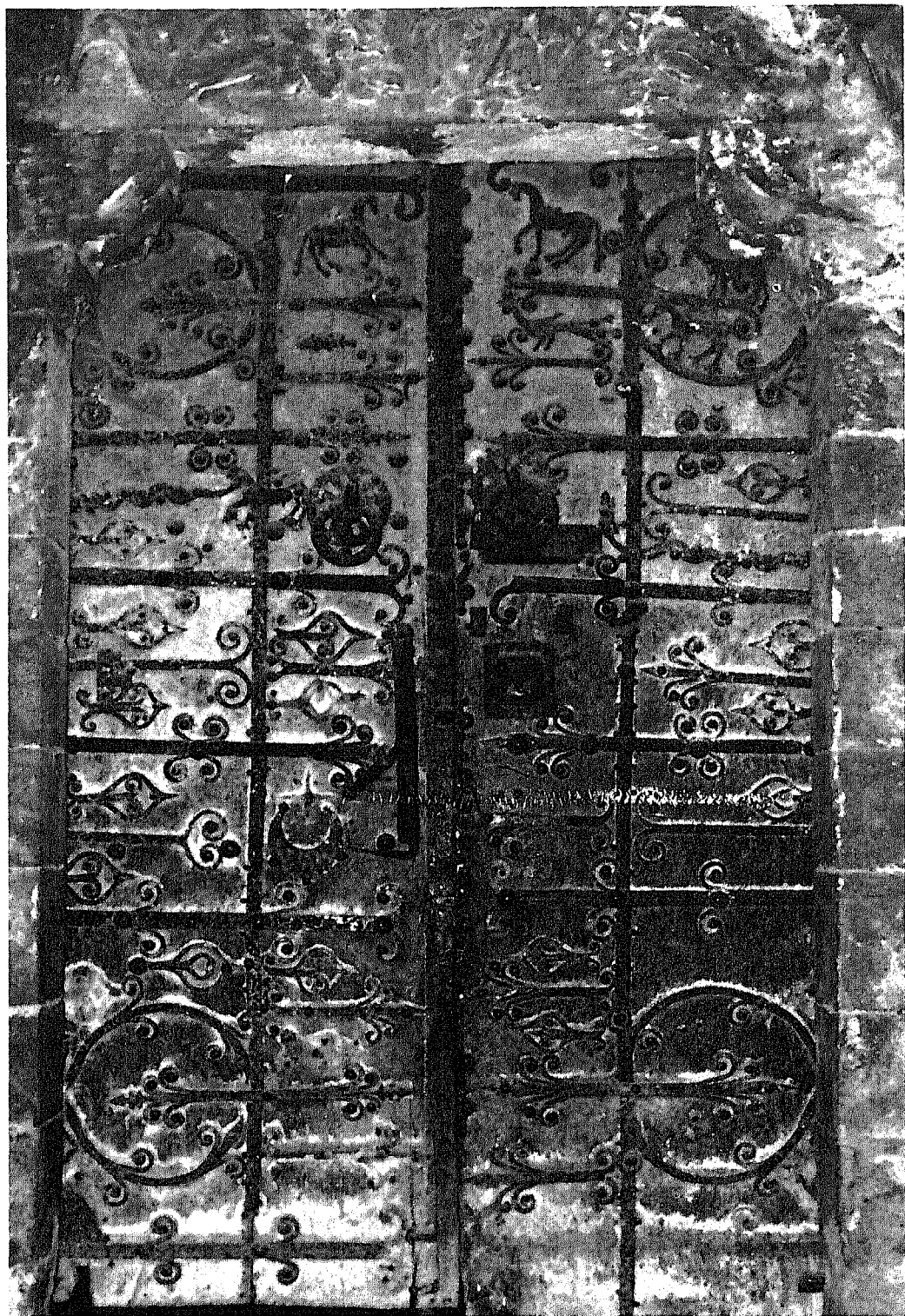
Lám. 2 Puerta de la ermita de Nuestra Señora de Tres Fuentes de Valgañón
