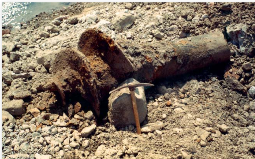
Extremo roscado de un pilote metálico del puente de Santo Domingo, aparecido al realizarse las obras en el cauce en el año 1993
