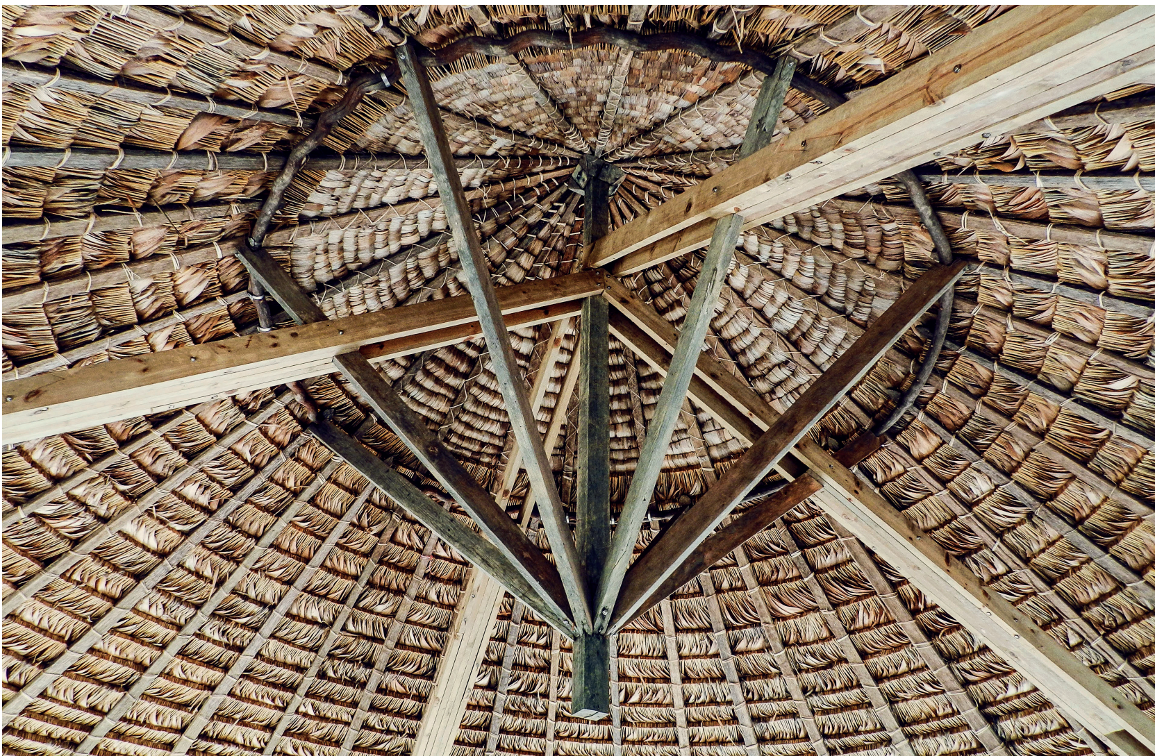
Detalle interior bajo cubierta.
