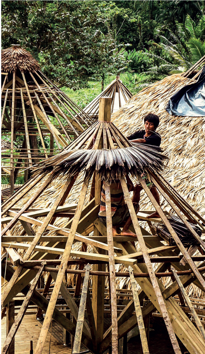
Proceso constructivo de una cubierta.
