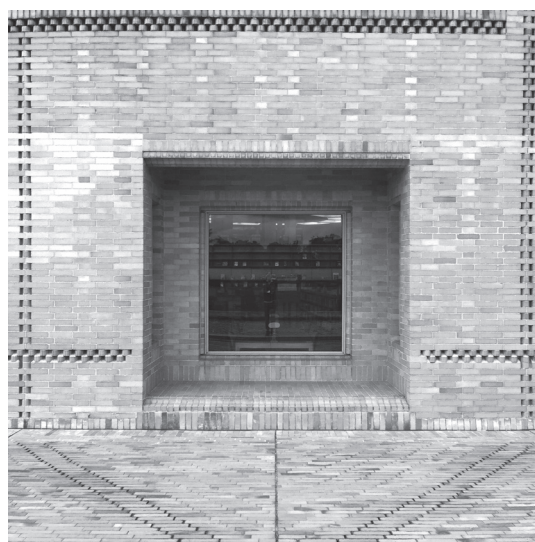
Figura 3. El muro en ladrillo. Biblioteca Virgilio Barco. Fuente: el autor
