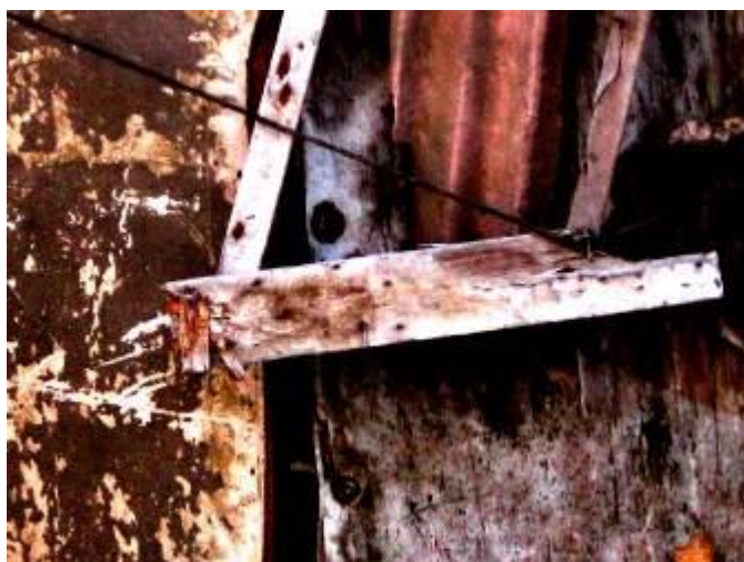
23 Fachada de mi vecino, Asentamiento Humano Hijos de Grau. Ventanilla- Callao. 2004
