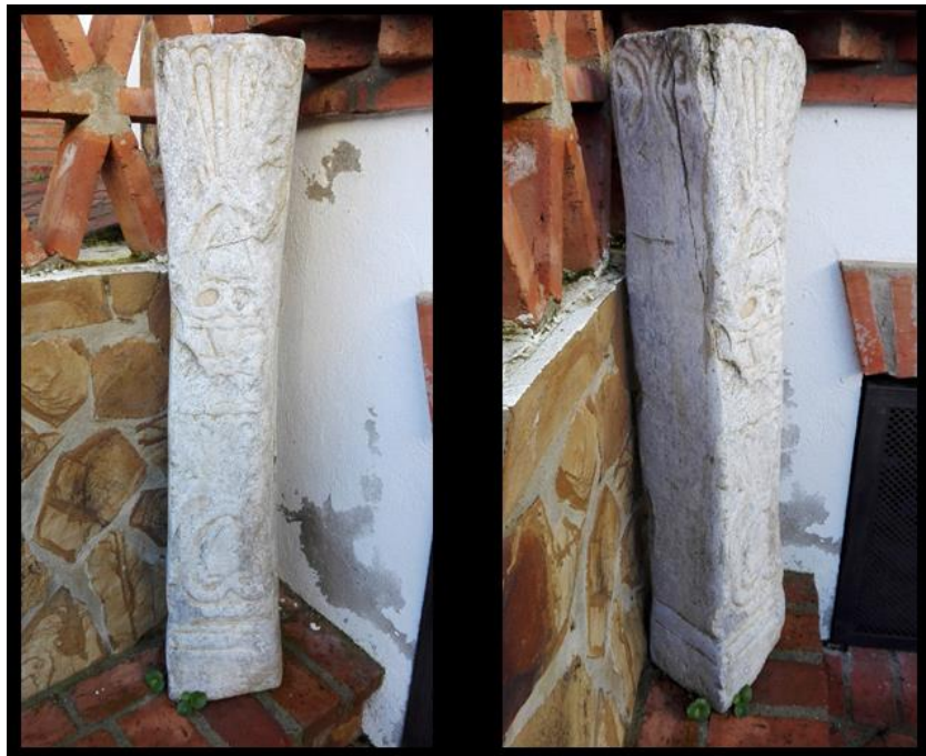
Fig. 10: Pilastra, C/Fragua, Alange.
