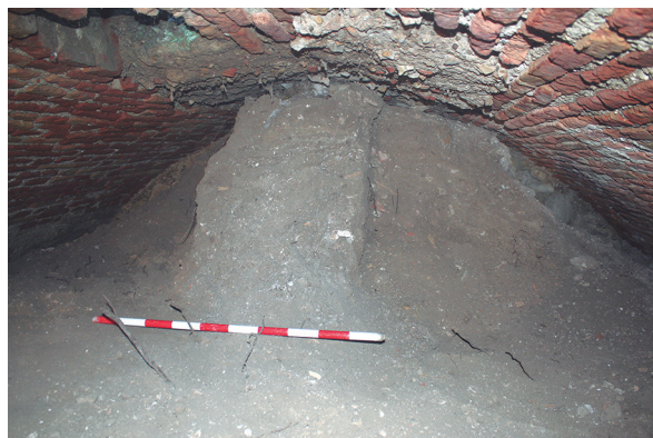
Lám. 19: Depósitos correspondientes al Periodo II en proceso de excavación.
