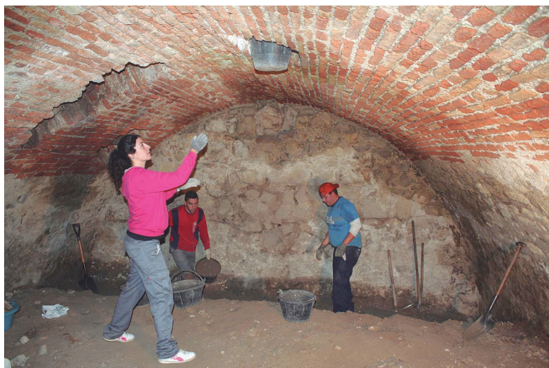
Lám. 8: El desescombro del aljibe en proceso de ejecución. Ya se observa la secuencia de la edificación de la estructura hidráulica, con mampostería, sillarejo y ladrillo.
