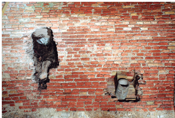
Lám. 2: Ejemplo de roturas postmedievales en la bóveda del aljibe. Roturas 2 y 3.
