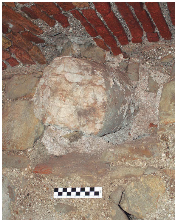
Lám. 10: Respiradero original del aljibe, amortizado con un fragmento de fuste de columna.
