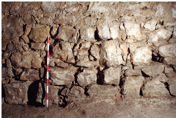
Lám. 6: Detalle de la parte inferior de los paramentos de mampostería del interior del aljibe.
