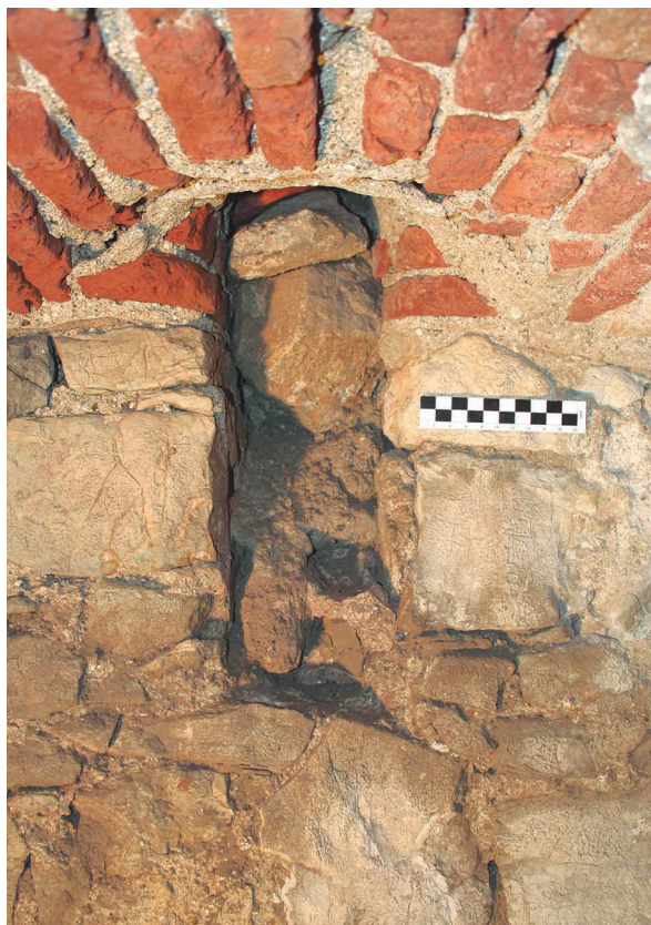
Lám. 9: Entrada original de agua al aljibe, actualmente condenada.
