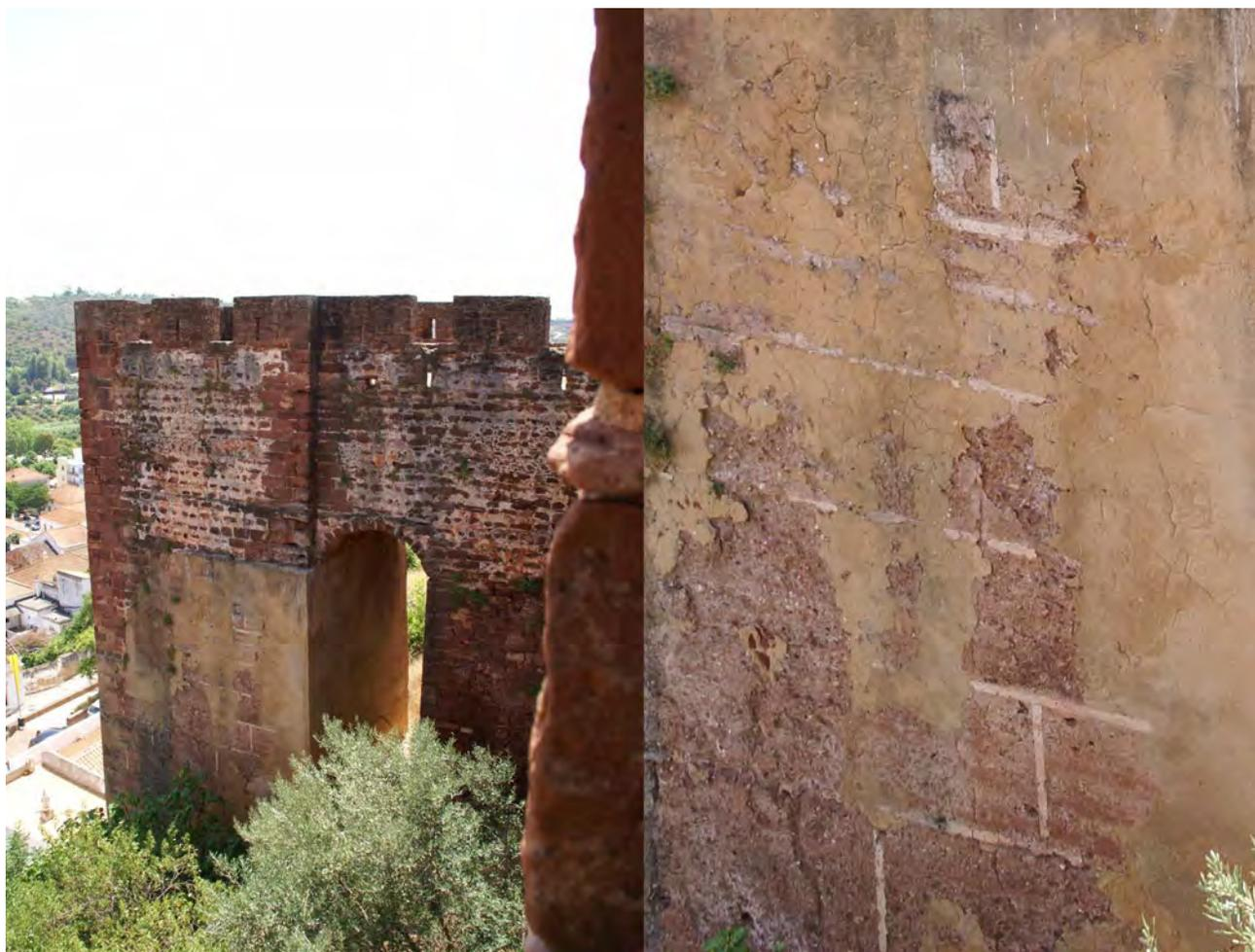
Fig. 5. Torre albarrana de la alcazaba de Silves y detalle de su decoración de Falso Despiece de Sillares. Agosto 2011.
