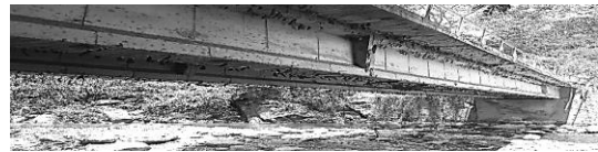
Fig. 1 Puente El Ramo. Autores.
