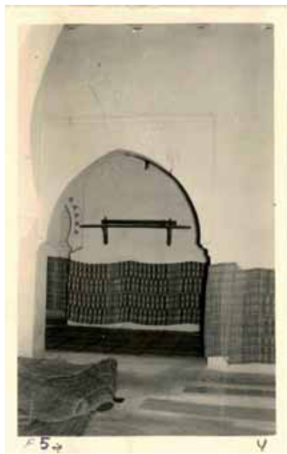
Fig.11. Detalle interior zagüia (Archivo Sierra Ochoa).
