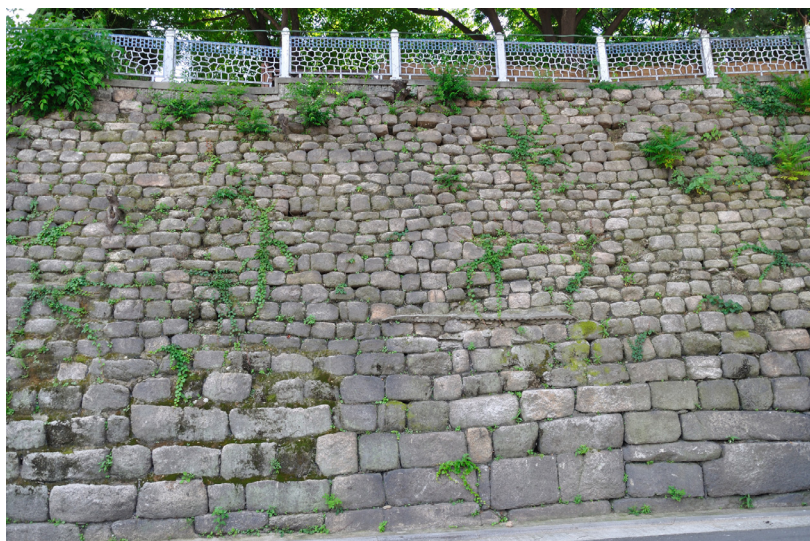
Imatges 5 i 6. Detalls del parament de blocs de pedra de la muralla de Hanyang, Seul (fotografies de l'autor)
