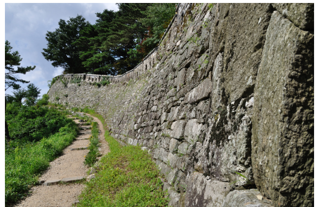
Imatge 20. Detall del parament de blocs de pedra de la muralla de Namhan-sansông (fotografia de l'autor)
