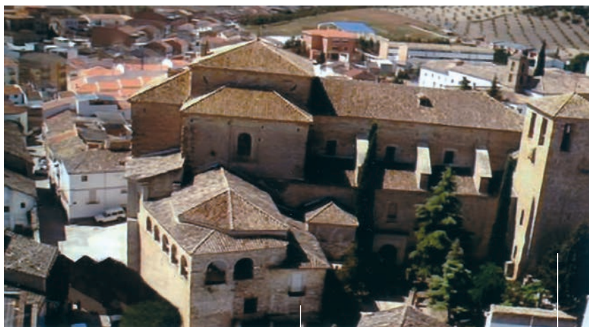
Casa del Sacristán y antigua torre junto a la que estuvo probablemente unida la Capilla de los Sevillanos
