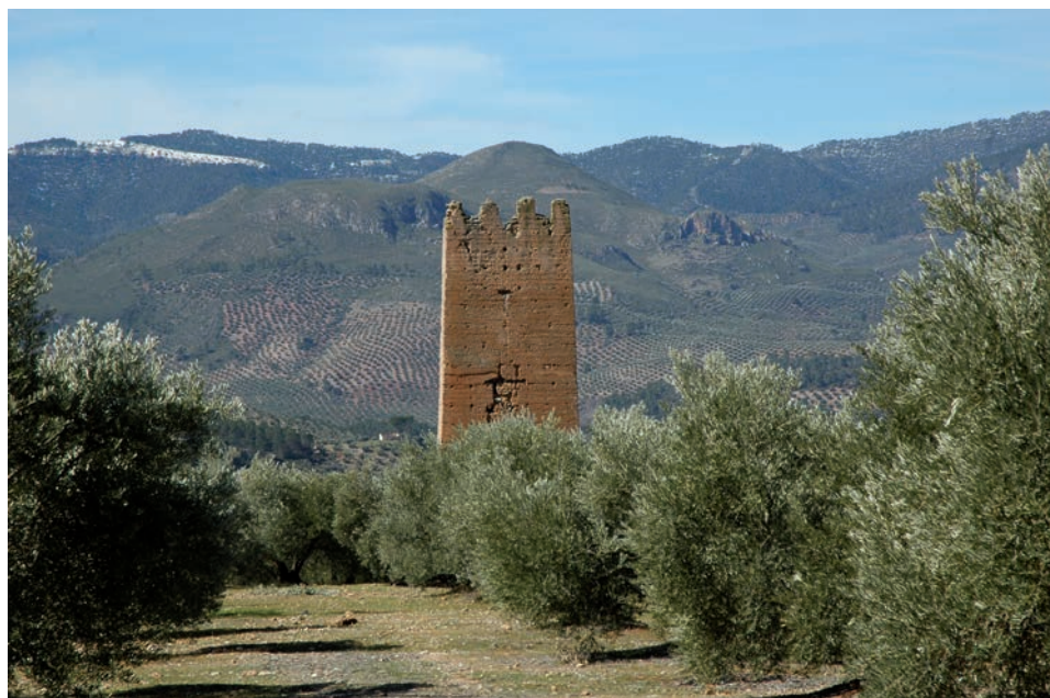
Fig. 13a.- Atalaya Sur de Santa Catalina. Se observa un primitivo hueco de acceso tapiado en época medieval para conformar una saetera o aspillera. Esta torre mantiene prácticamente intactos sus merlones originales
