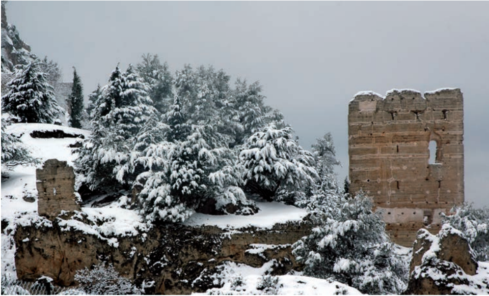
Fig. 8a.- Restos conservados de la torre del recinto amurallado de Góntar, Castillo de Góntar, tras su restauración científica.
