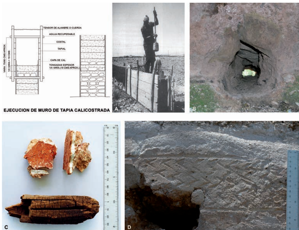
Fig. 7.- A/ Ejecución de un muro de tapia en Marruecos. B/ Mechinal encofrado en las torres del valle de Segura, con piedras apoyadas unas en otras, para permitir la recuperación de la aguja de apoyo de los tapias. C/ Muestras de aguja y de calicostrados exteriores de la tapia, en los que se observa con nitidez su espesor. D/ Marcas con grafías geométricas encontradas en los calicostrados exteriores de la torre de Góntar.
