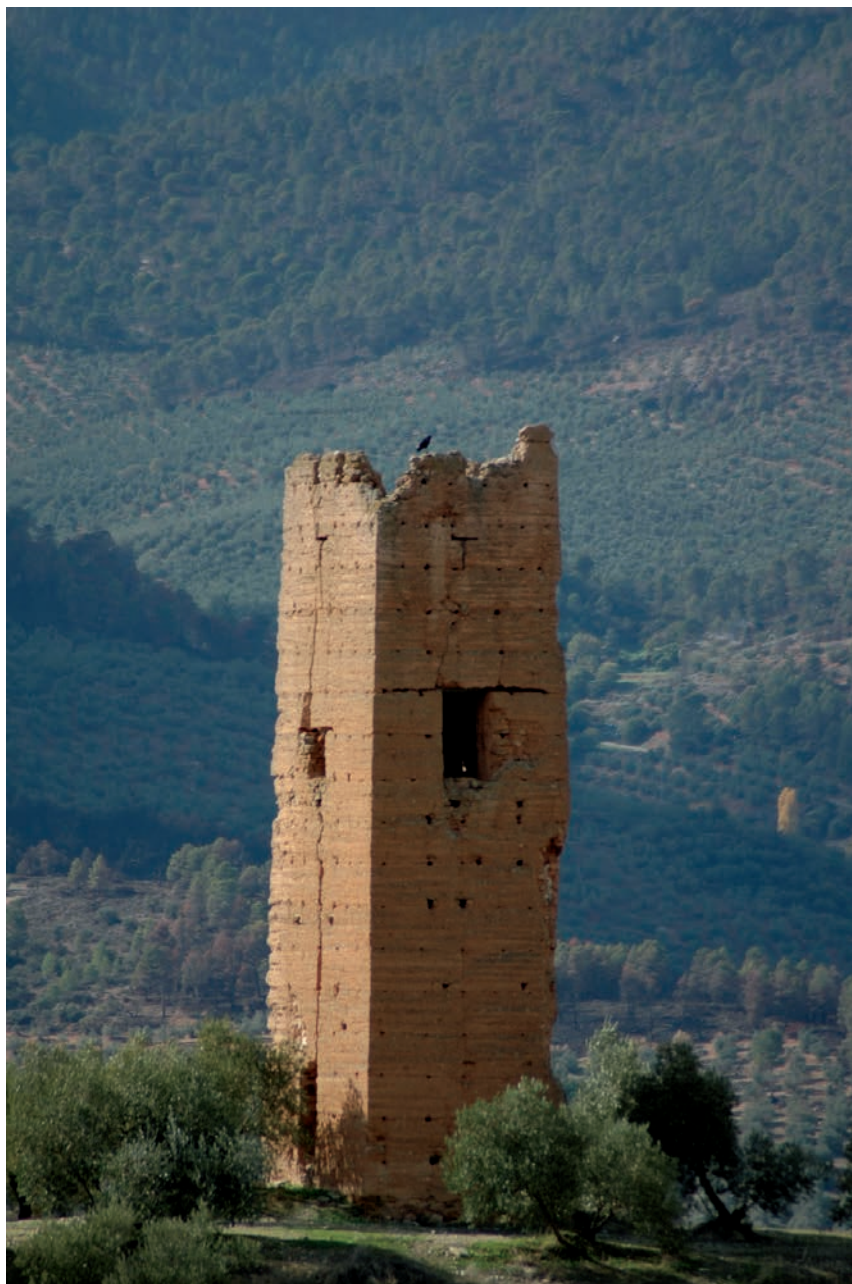
Fig. 11.- Atalaya Norte de Santa Catalina. Los huecos que se aprecian eran los accesos originales. Se observan los mechinales donde estaba alojadas las plataformas o andamios para acceder a la misma.
