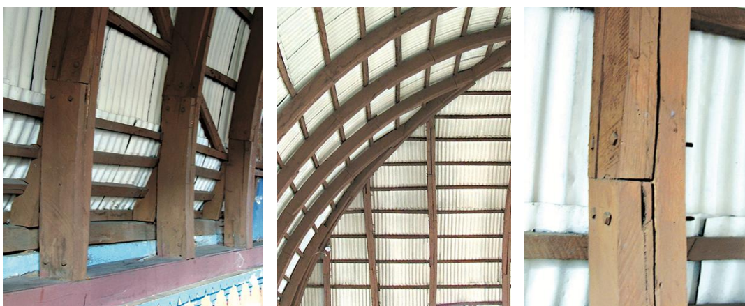
Imagen 15: Detalles del sistema constructivo Delorme.
