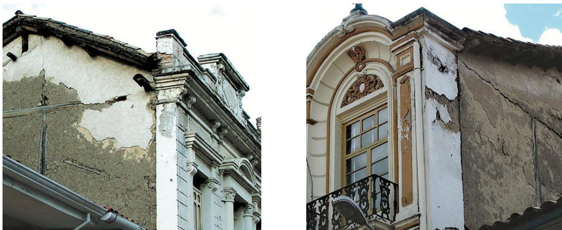
Imagen 10: En la arquitectura las fachadas son construidas con materiales pétreos y el bahareque se mantiene para elementos ocultos.
