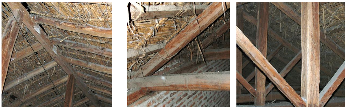
Imagen 15: Estructura de cubierta a 2 y 3 aguas.
