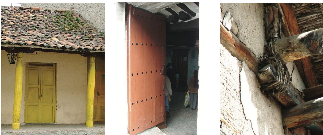
Imagen 4: Ejemplos de utilización de la madera en las edificaciones coloniales.
