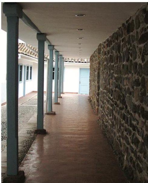
Imagen 3: Madera utilizada para los corredores de los patios.
