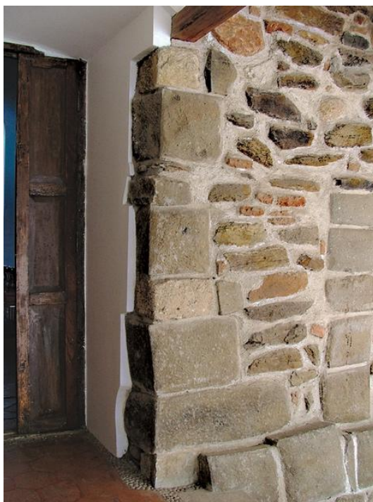
Imagen 1: Muro de la Iglesia Mayor de la ciudad de Cuenca, se puede observar piedras incas en los muros.
