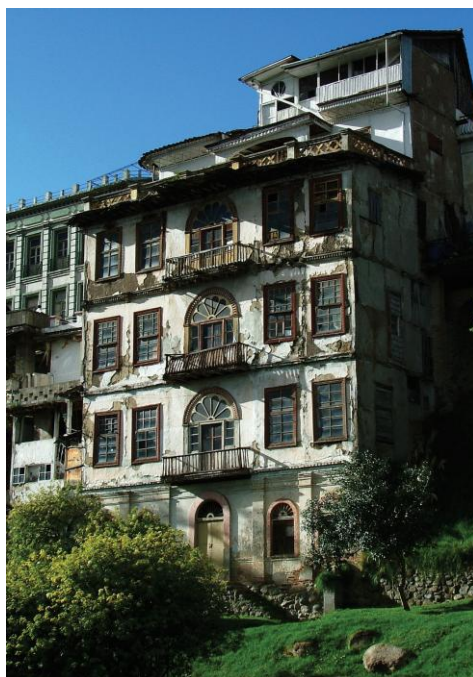
Imagen 11: Se empieza a utilizar el sistema constructivo de bahareque para edificaciones de más de 2 niveles.
