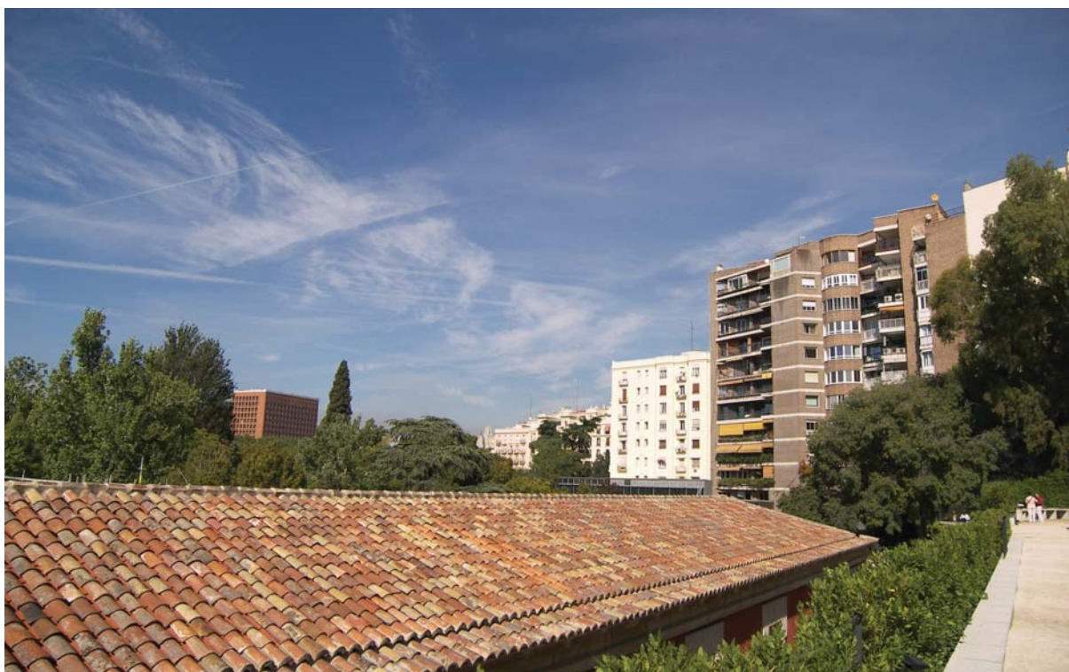
(Fig. 4) Viviendas en calle Espalter. Fotografía de Daniel Rincón de la Vega.
