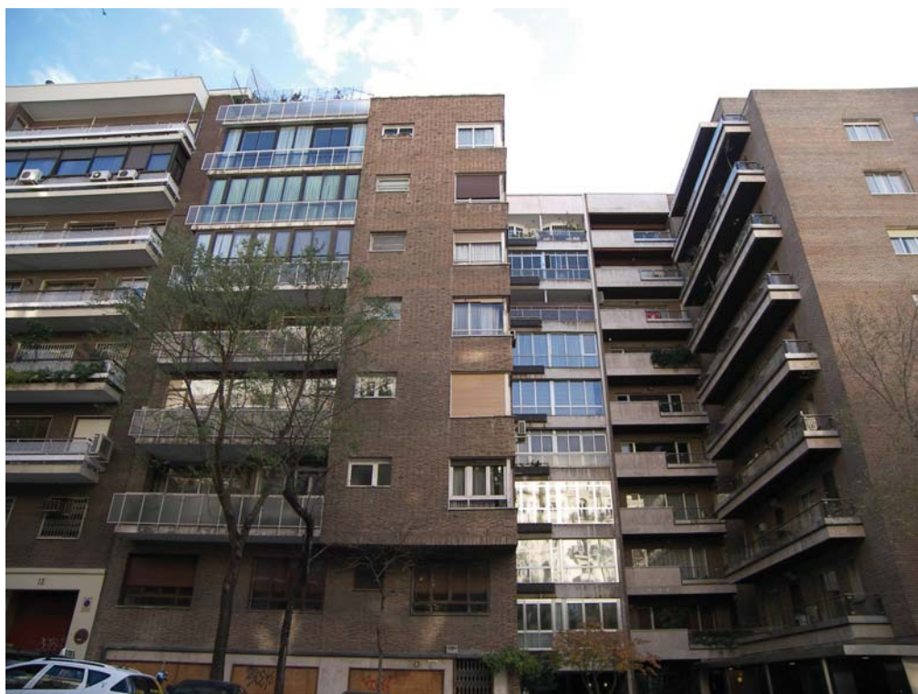
(Fig. 2) Viviendas en calle Espalter. Fotografía de Daniel Rincón de la Vega.
