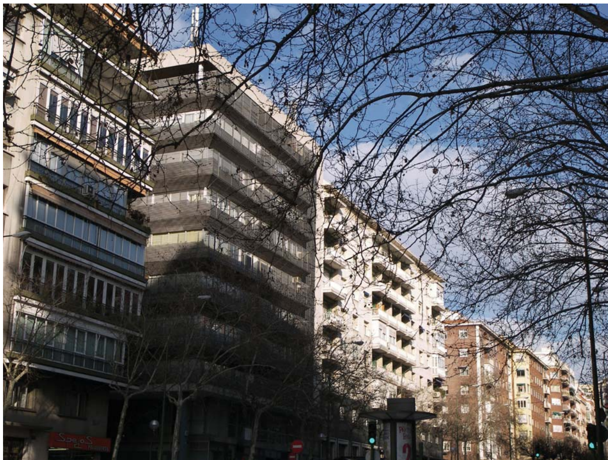
(Fig. 7) Viviendas en Cea Bermúdez c/v San Francisco de Sales. Fotografía de Daniel Rincón de la Vega.
