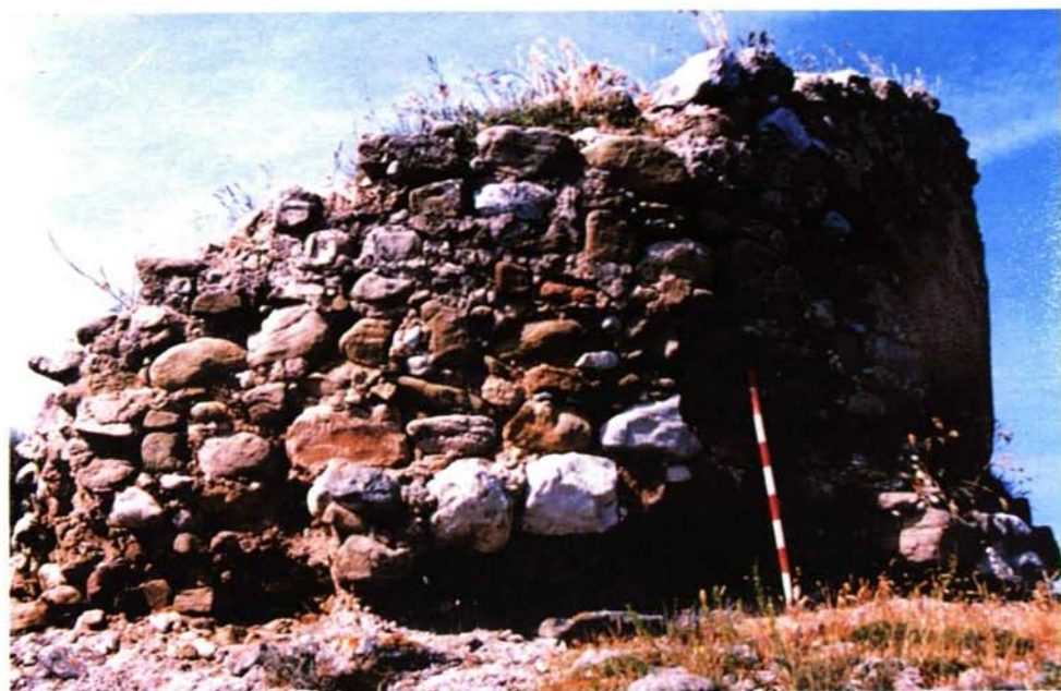
Lámina 1. Torre de vigilancia: lado Oeste.
