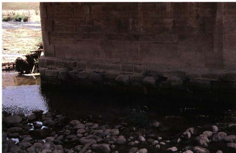
4. Detalle de una de las pilas del puente de Nájera, cimentada sobre restos de otra de época moderna.
