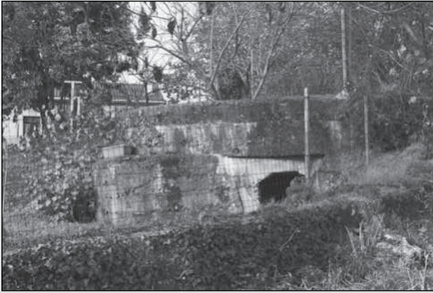
VISTA POSTERIOR DEL NIDO DE AMETRALLADORAS DE RAÑECES QUE PRESENTA NUMEROSAS INSCRIPCIONES EN EL HORMIGÓN. FOTO FLORENTINO GONZÁLEZ
