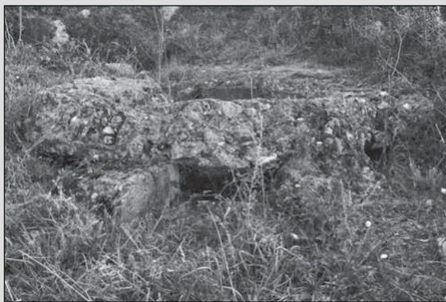
NIDO DE FUSIL AMETRALLADOR EN EL CUETU DE RAÑECES, CON LA TECHUMBRE DESTRUÍDA PARA LA EXTRACCIÓN DE LA FERRALLA. FOTO FLORENTINO GONZÁLEZ
